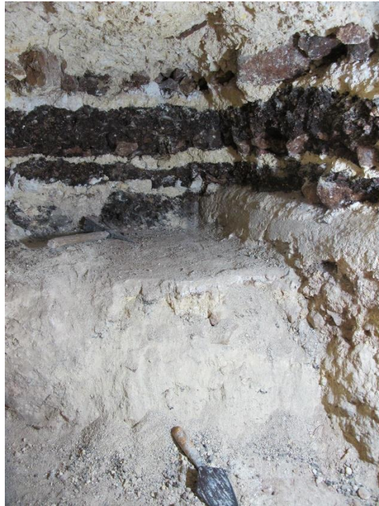
Figura 9.4 Relleno constructivo que cubre el Edificio Cacao (Fotografía por E. Arredondo).
