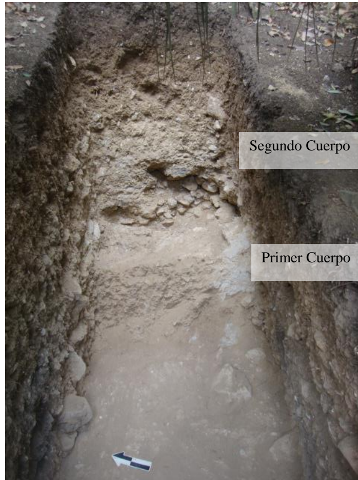
Figura 6.6. Cuerpos de mampostería de la Estructura 13R-1 vistos desde el oeste (Foto por J. Ponce)
