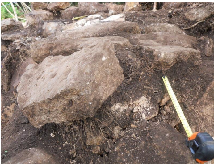
Figura 4.47- Rocas de base y capa de chich combinada con tierra, se aprecia una pequeña porción de estuco. Perfil oeste.
