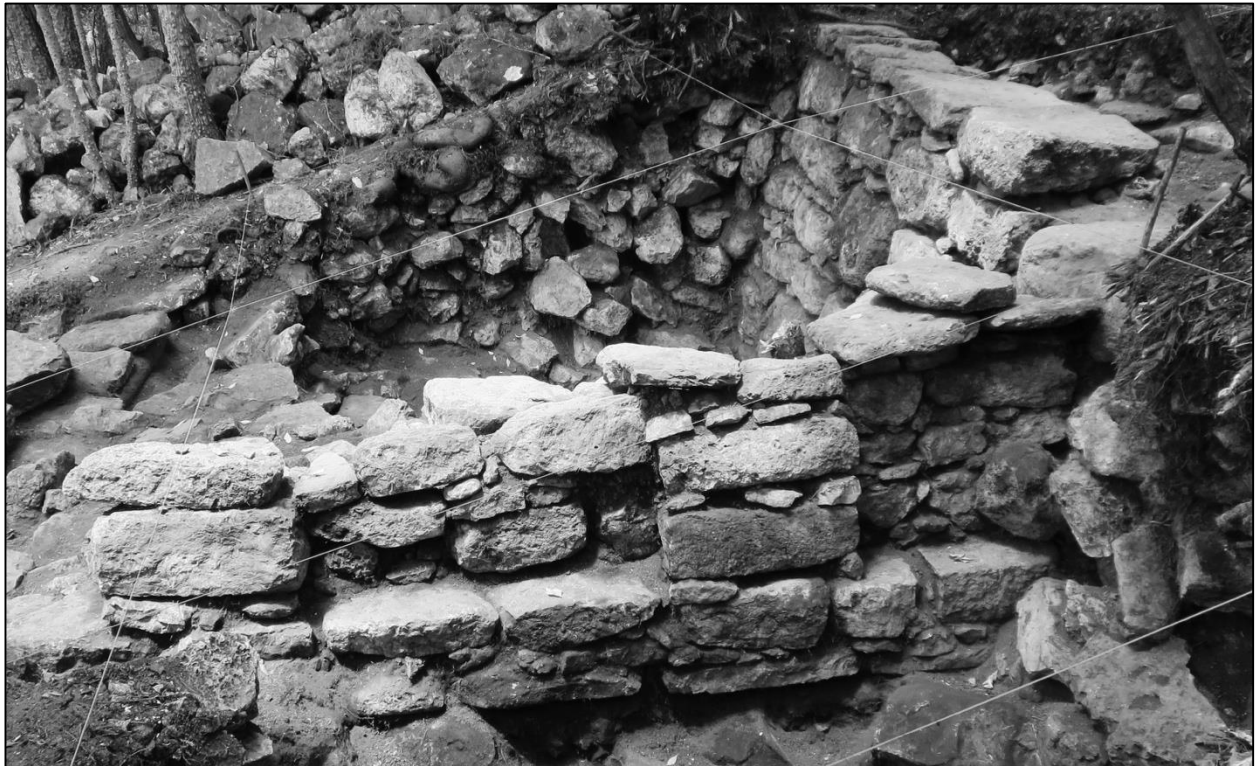
Figura 8.14: Foto (mirando al sur) de las unidades 5, 6, 7, y 8 de la Sub-operación A. Se ve el muro 2 (en frente), el muro 3 (atrás y a la derecha) y el muro 1 (atrás y a la izquierda).
