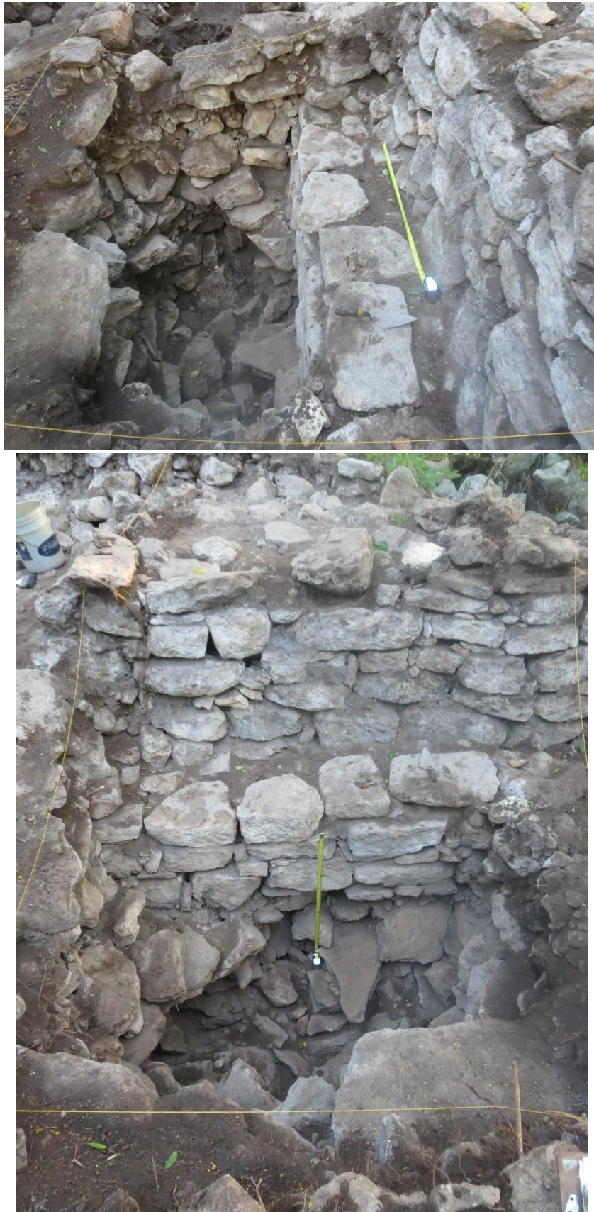
Figura 9.12, Arriba: mostrando relación entre F9 (derecha) y F6 (izquierda), así como relleno constructivo compartido. Abajo: F9 visto desde el sur y relleno nuclear.
