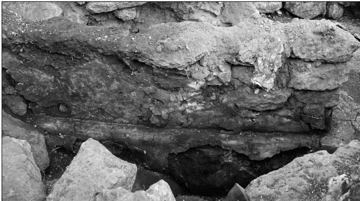
Figura 8.51: Fotografía del Muro 5 y su plinto, mirando al este.
