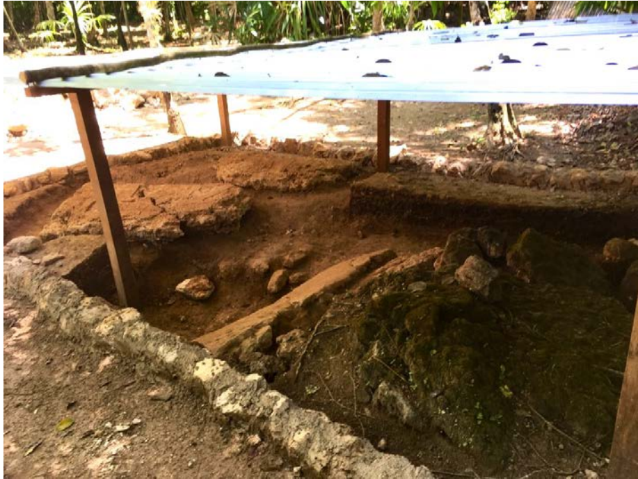
Figura 2.20 Cubierta protectora provisional para la Estela 7 Foto. Juan Carlos Pérez
