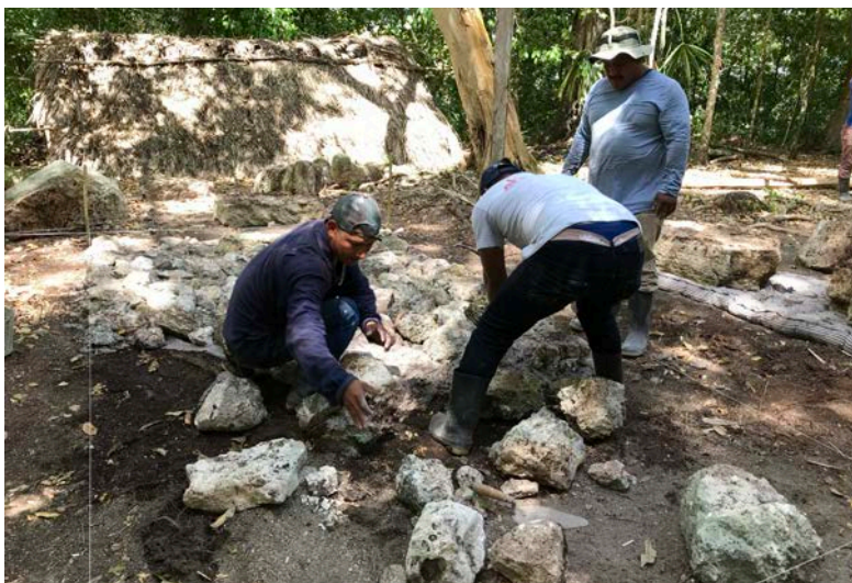
Figura 7.5 Inicio del proceso de construcción de plataforma de la estela 1. Foto Griselda Pérez
