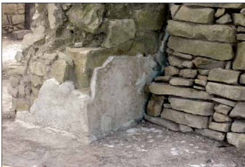
Figura 40. El muro seco construido probablemente en la etapa posdinástica: (a) vista general; (b) detalle de su desplante. Archivo del Proyecto Grupo de las Cruces.
