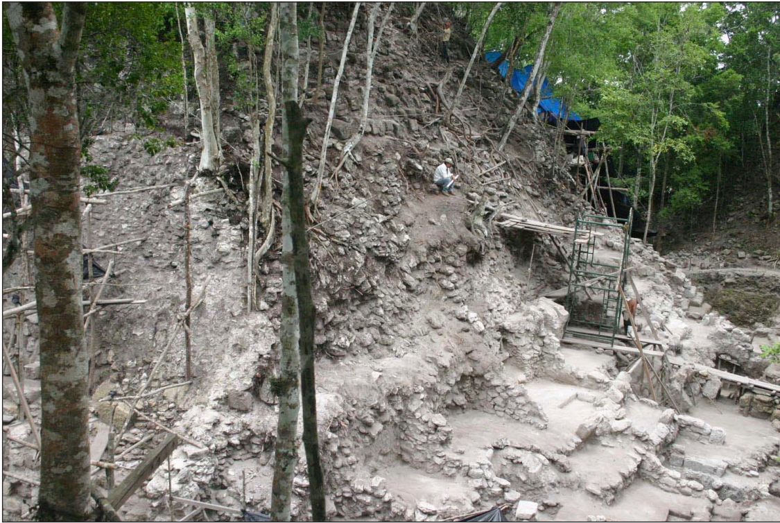
Figura 9. Fachada principal del Edificio 2A8-2; se observa la serie de cuartos construidos en la base durante la reocupación y el desmantelamiento de sus piedras de fachada en el Clásico Tardío y Tardío Terminal (foto E. Suyuc).
