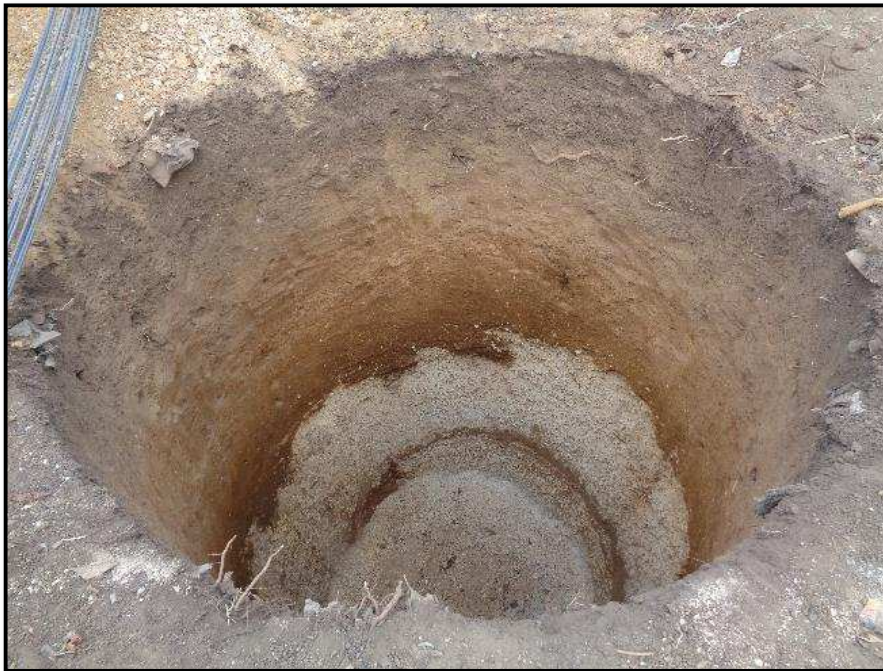
Figura 13.10. Vista general de Operación 13-3 en proceso de excavación. Foto María Corado.
