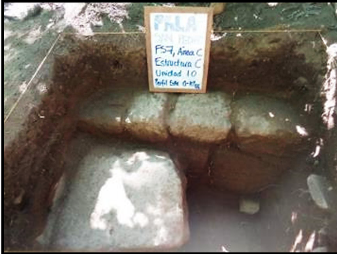
Figura 14.18. Perfil este de la Operación 7c-10, mostrando muro de la Estructura C-3. Foto María Corado.
