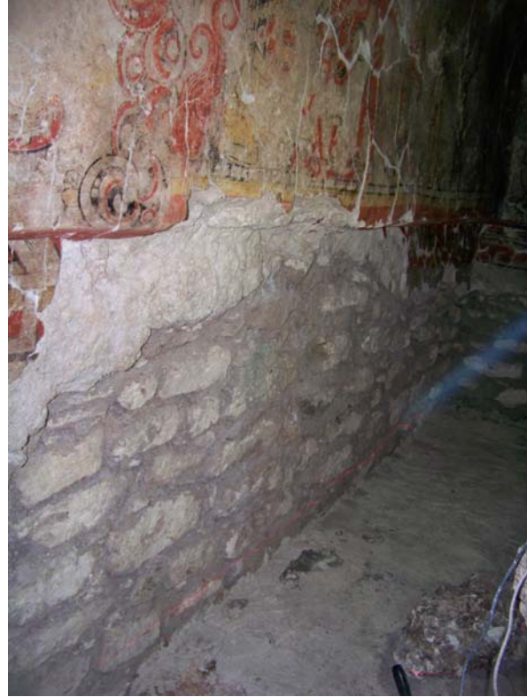
Fig.3.2.8. Nivelación y consolidación del piso interior de sub-1a, aproximadamente, 0.60 mts. Sobre el original. Foto A. Coronado.
