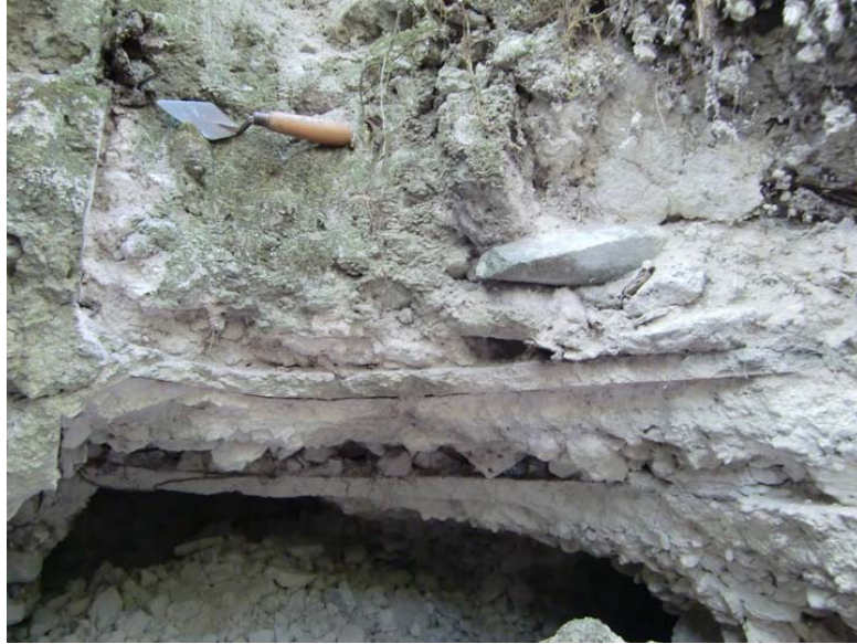
Fig.1.3. 4. Saqueos en búsqueda de entierros, bajo los pisos con daño a la arquitectura. Nótense muro (lado izquierdo), fragmento de metate encima de piso (lado derecho), dos etapas de pisos estucados con remodelación del más reciente (encima), y colapso de la arquitectura bajo el piso inferior. Foto Runggraldier.
