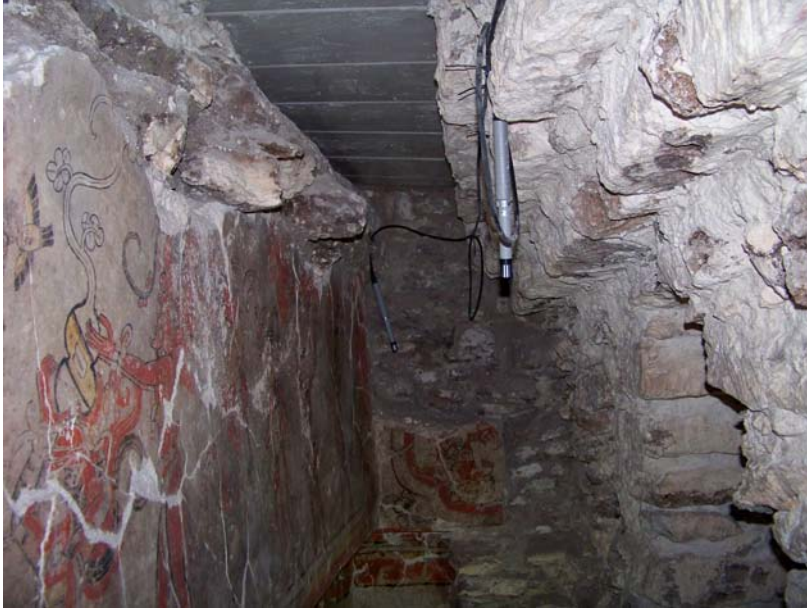
Fig.3.2.16. Consolidación del túnel de circulación norte y ventana de observación #4. Foto A. Coronado
