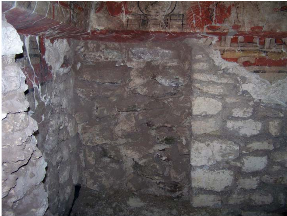
Fig.3.2.5. Ventana de observación #8 en túnel de acceso norte. Foto A. Coronado.
