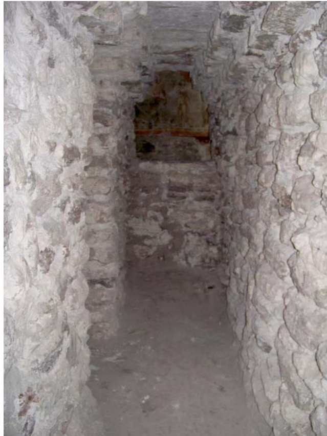
Fig.3.2.17. Consolidación del túnel norte de mantenimiento en sub-1a. Foto A. Coronado.
