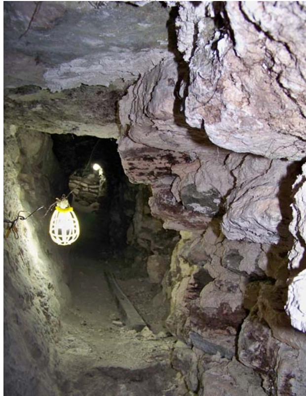
Fig. 3.2.4. Túnel para paso de materiales de relleno para túnel 70. Foto A. Coronado.
