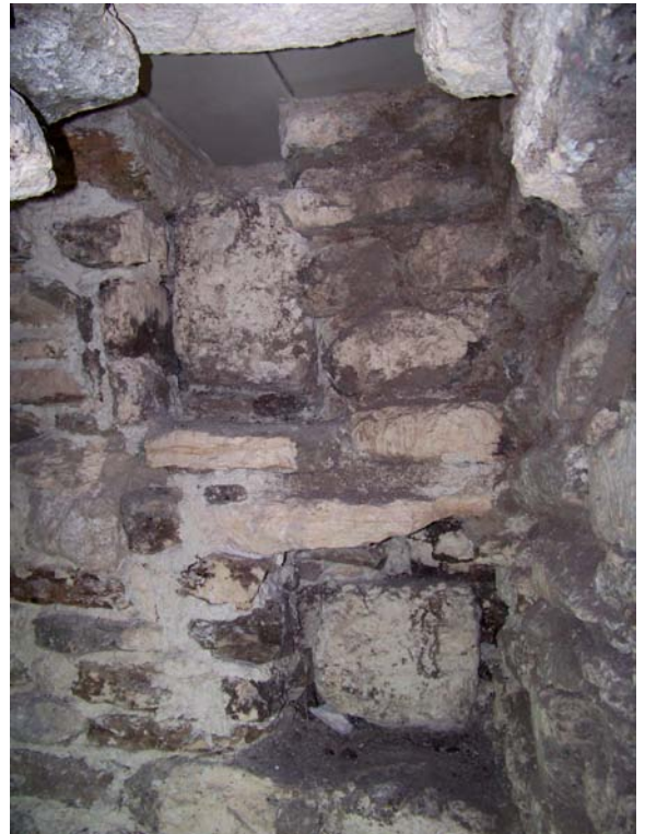
Fig.3.2.7. Ventana de observación #5 al final del túnel de acceso sur . Foto A. Coronado.
