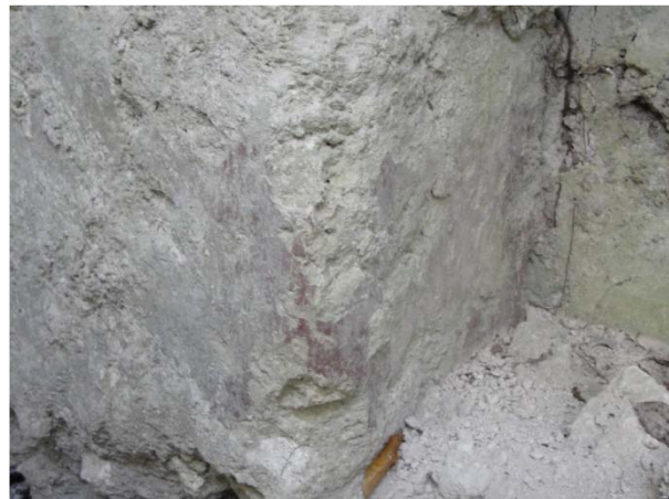
Figura.2.8.23 . Muro con restos de pintura roja. Foto. J. Ruane
