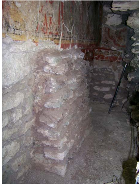
Fig.3.2.11. Apoyo estructural en muro norte interior de sub-1a. Foto A. Coronado
