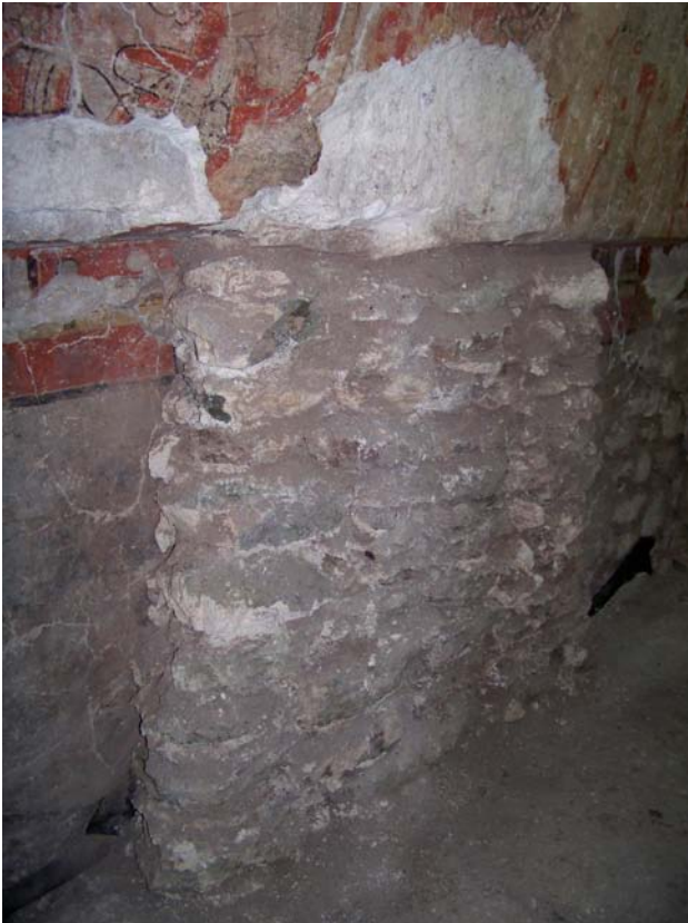
Fig.3.2.9. Talud de apoyo para friso pintado en muro oeste, frente a ventana de observación #3. Foto A. Coronado.
