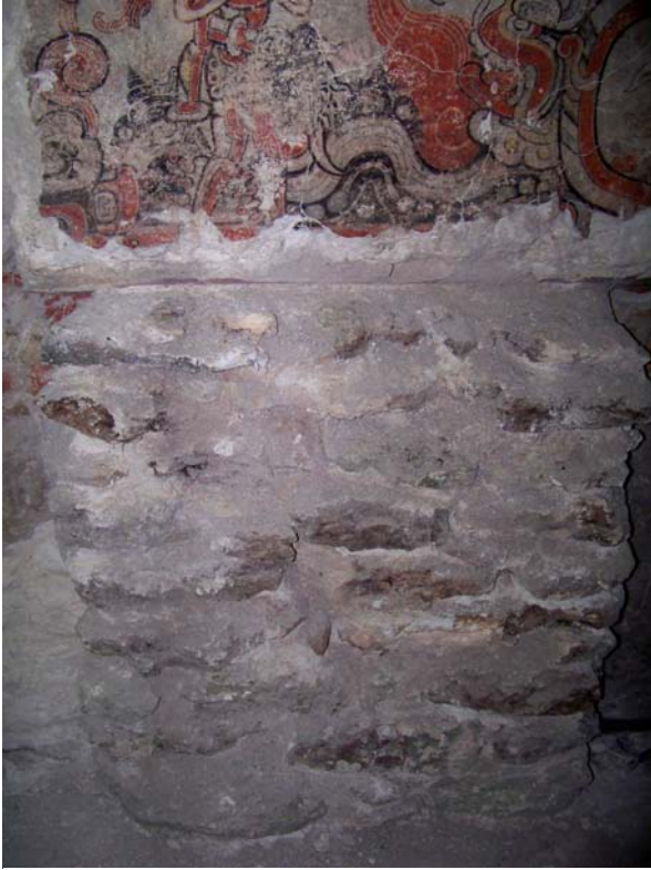
Fig.3.2.10. Apoyo estructural para mural en esquina noroeste de sub-1a. Foto A. Coronado
