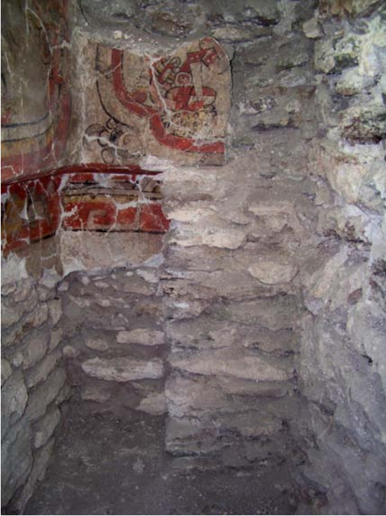
Fig.3.2.12. Apoyo estructural en muro este interior de sub-1a. Foto A. Coronado.
