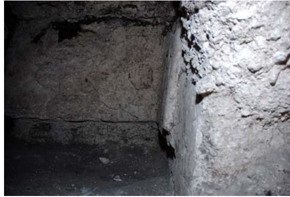
Foto 6. Muro entrante y saliente en esquina sur-este. Foto B. Beltrán.
