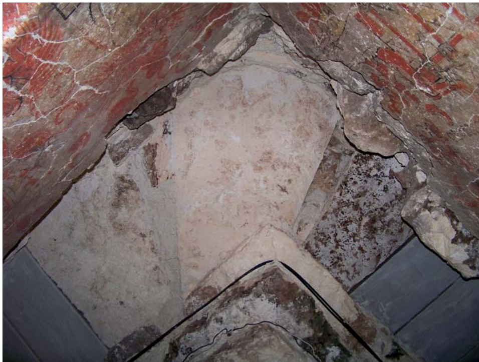
Fig.3.2.15. Capa de mezcla aplicada sobre las canaletas de fibra de vidrio para evitar condensación. Foto A. Coronado.
