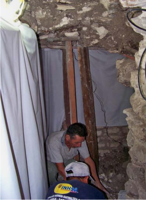
Fig.3.2.18. Colocación temporal de tela sintética como protección de los muros durante trabajos de excavación y consolidación de túneles en sub-1a. Foto A Coronado
