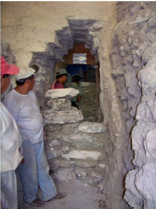
Fig.3.2.20. Tapones de mampostería para túnel de acceso principal a sub-1a. Foto. A. Coronado
