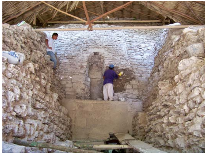
Fig.3.2.19. Modificación y capa de lodo en taludes de contención al exterior del lado este de pinturas. Foto A. Coronado.
