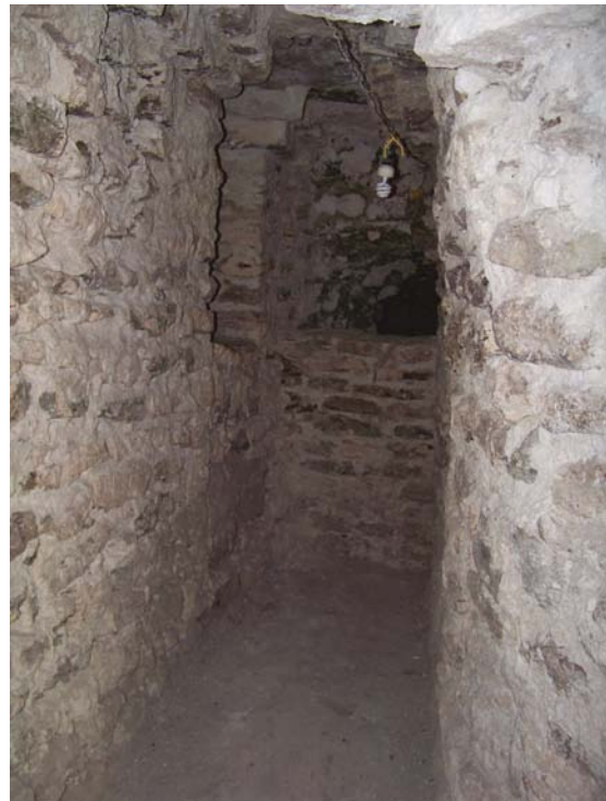
Fig.3.2.3. Relleno de vano norte en esquina noroeste de sub-1a. Foto A. Coronado
