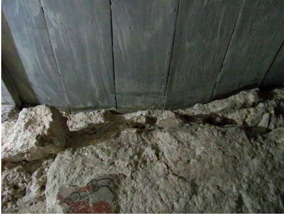
Fig.3.2.14. Cubierta de esquina noroeste de sub-1a, a base de 3 piedras calizas triangulares. Foto A. Coronado.
