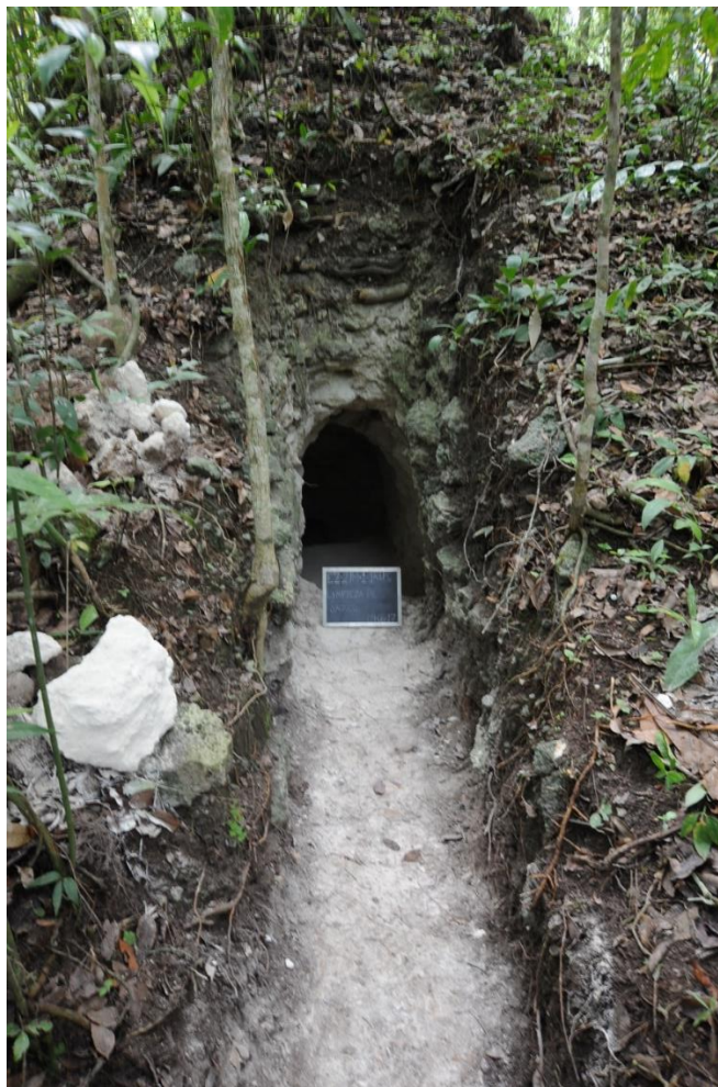
Figura 4.10. Inicio de la limpieza de saqueo de la unidad EZ-21M-1. (Foto por Rony Piedrasanta, 2017).
