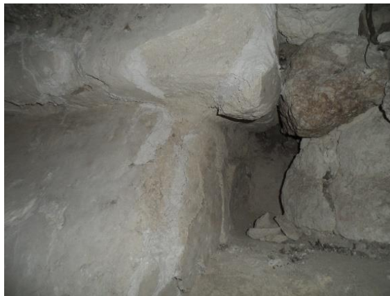
Figuras 5.9 y 5.10. Fisura y área de tratamiento en estucos de Estructura M7-1 previo a limpieza y consolidación.
