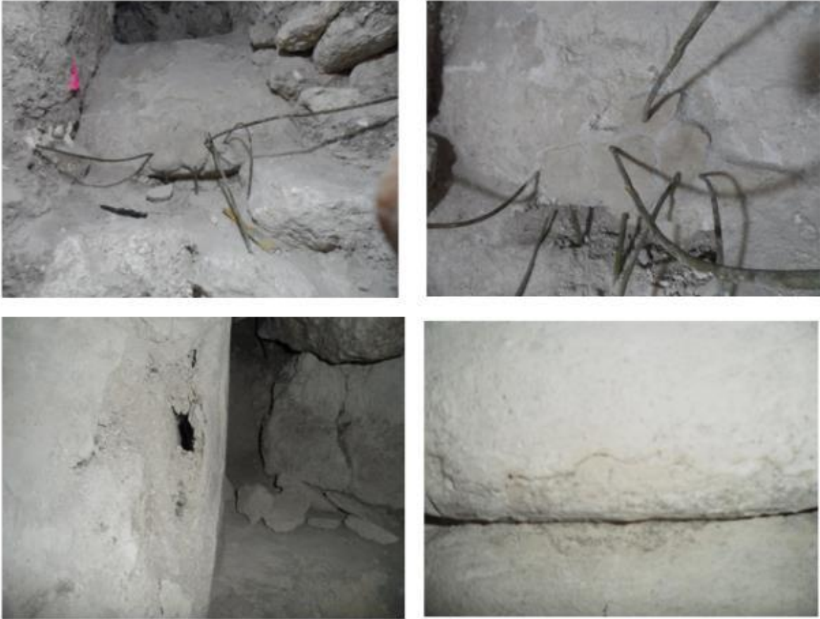
Figuras 5.11, 5.12, 5.13, y 5.14. Trabajos realizados en el Sitio El Palmar; se realizó limpieza e integración de fragmentos a las paredes, como aglutinante se utilizó cal y arena en proporciones 2:1. Como apoyo y refuerzo a las uniones se utilizaron punteros, los cuales fueron removidos antes de cerrar los trabajos de excavación.
