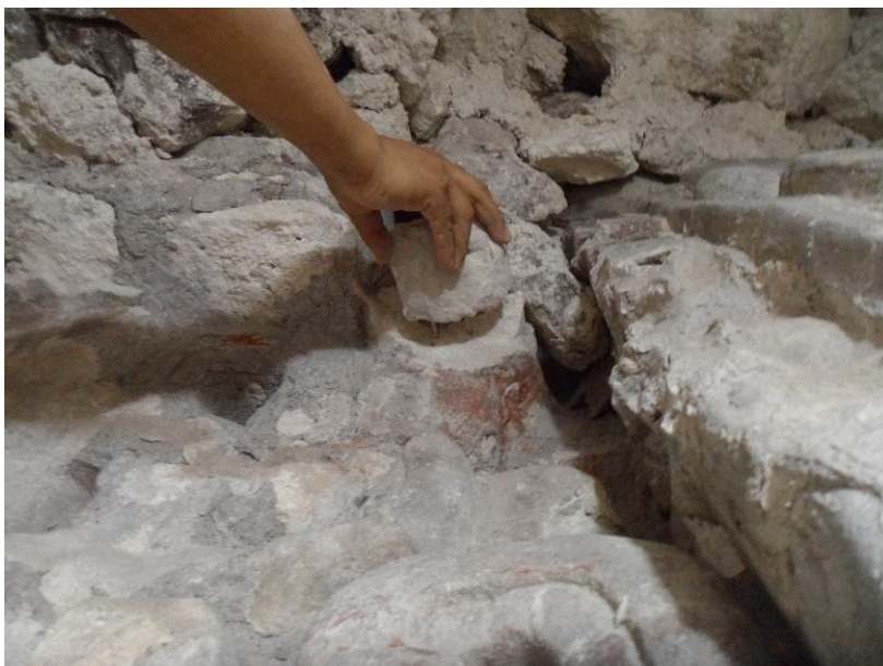
Figura 5.19. Colocación del fragmento en el muro, las perforaciones de ingreso de los vastagos fueron efectuadas con barreno y broca de 1/8. Foto H. Cervantes 2019
