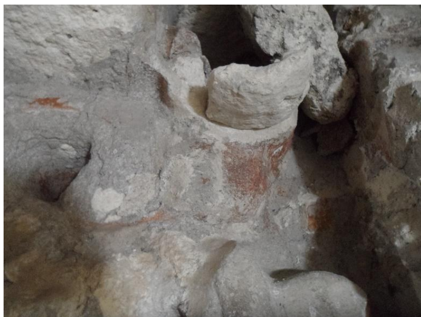
Figura 5.20. Fragmento situado en su lugar y sostenido unicamente por los vastagos, posterior a esto se le colocó la capa de estuco en proporción 1:1 para darle el volumen del estuco original. Foto E. Pérez 2019
