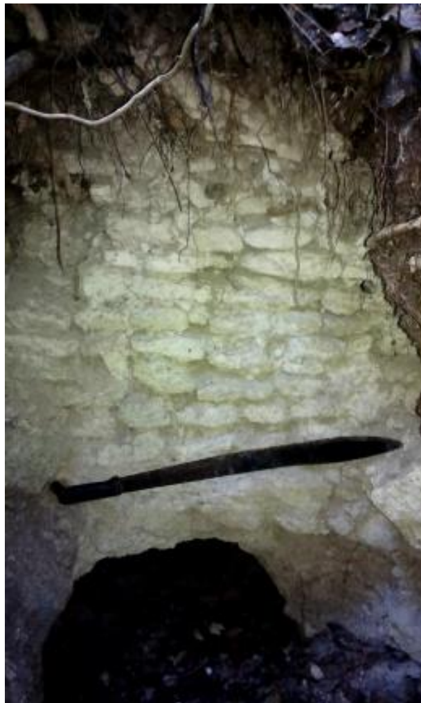
Figura 6.10. Registro de saqueos. Detalle de muros expuestos por saqueo, compuesto de piedras calizas pequeñas. (Fotografía: Rafael Cambranes, 2019).
