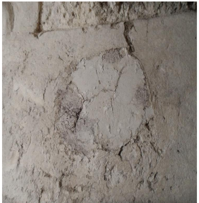
Figura 5.30. Fotografías que muestran la limpieza del área de donde se retiró el elemento, se removió sedimentos y restos de raíces por medio de brochas y antes de colocar el fragmento se humectó el área con agua de cal. Foto H. Cervantes 2019
