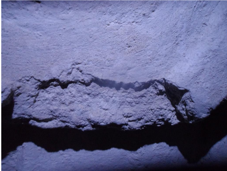
Figura 5.25. Orejera con exposición de estratos, se consolidó con lejía de cal y se hizo estuco con arena de las excavaciones in situ , que concuerda con la tonalidad blanca del estuco original, esta fue finamente cernida y mezclada con la cal para después efectuar la consolidación y resanes. Foto: Edwin Pérez, 2018.
