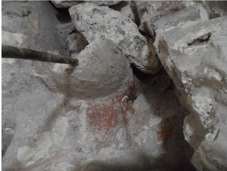
Figura 5.15. Fragmento unido al muro con capa de estuco y una varilla de fuerza para una mejor adherencia en el proceso de fraguado. Templo del Sol Nocturno. (Foto E. Pérez. 2019).
