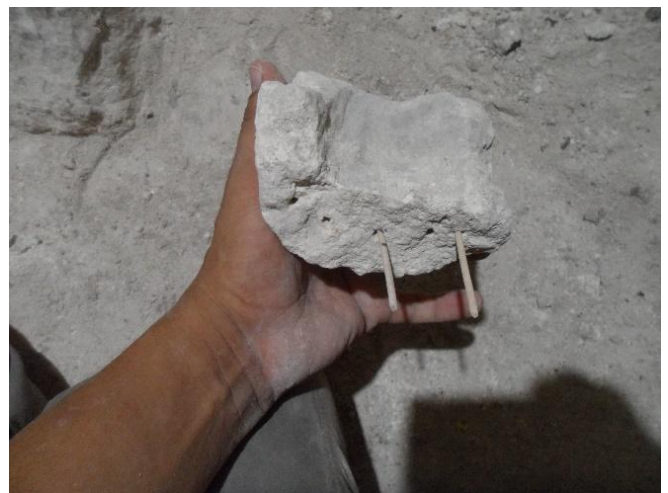
Figura 5.17 y 5.18. Fotografías que muestran el proceso de colocación de vastagos de madera utilizados como guía y soporte a la piedra tallada, las perforaciones se hacen en ambas partes a unir a fin de que el vastago tenga la función de soporte, posterior a esto se le colocó un resane de estuco en todo el contorno hasta llegar al grosor del estuco original. Fotos H. Cervantes 2019
