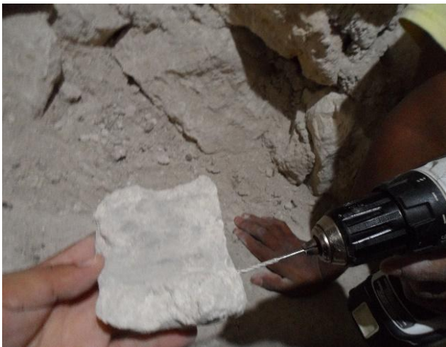
Figura 5.17 y 5.18. Fotografías que muestran el proceso de colocación de vastagos de madera utilizados como guía y soporte a la piedra tallada, las perforaciones se hacen en ambas partes a unir a fin de que el vastago tenga la función de soporte, posterior a esto se le colocó un resane de estuco en todo el contorno hasta llegar al grosor del estuco original. Fotos H. Cervantes 2019
