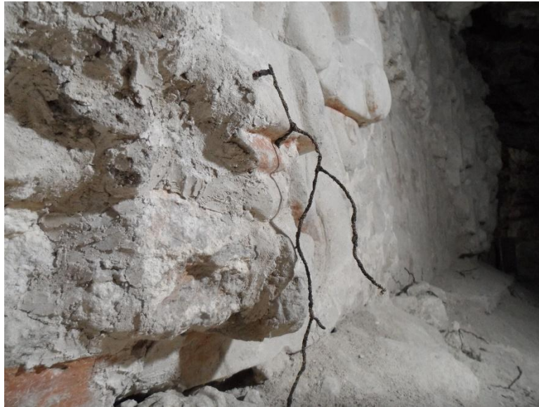
Figura 5.1. Canales de transporte de termitas subterráneas encontradas en los mascarones del Templo del Sol Nocturno en el Grupo el Diablo (Foto. E. Pérez 2019).
