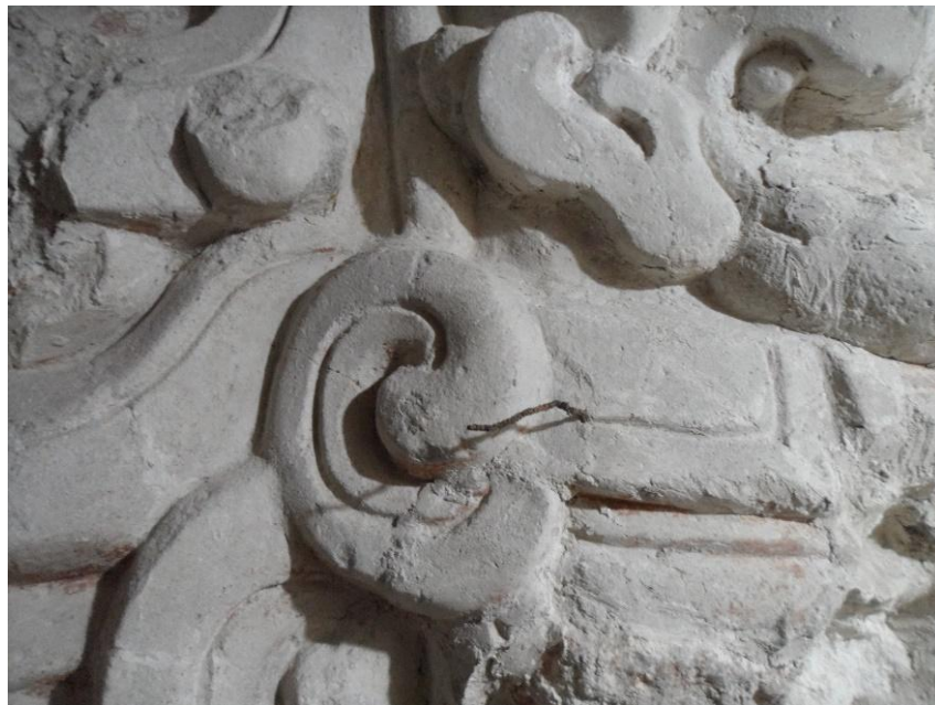
Figura 5.7. Camino de termita saliendo de uno de los muros del lado Oeste del Templo del Sol Nocturno (Foto E. Pérez 2019).
