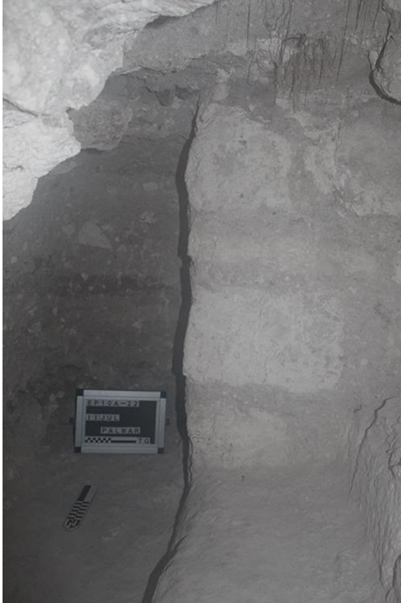
Figura 4.8. Articulación de la grada basal con el cuerpo arquitectónico sur de la Estr. K7-1-3 a . La arquitectura está construida con piedra y mortero y no está estucada (foto de T. Garrison).
