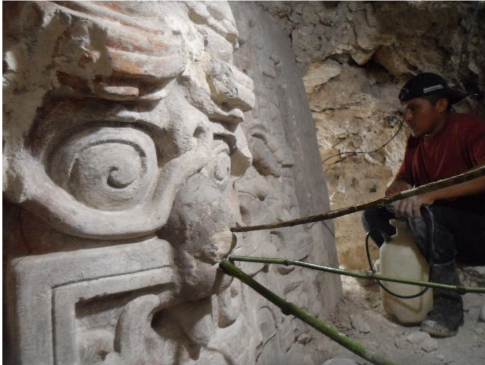
Figura 5.10. Nótese la nariz integrada nuevamente al mascarón con las varillas de soporte, al fondo se observa a Héctor Cervantes realizando aspersion de agua de cal. Templo del Sol Nocturno (Foto E. Pérez, 2019).
