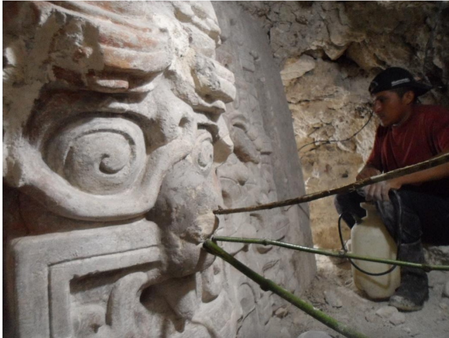
Figura 5.24. Fotografía en donde se reintegró el fragmento, como aditivo se utilizó cal y arena en 1:1 y como soporte al proceso de fraguado se colocaron varillas apoyadas en el túnel para ejercer una fuerza uniforme y evitar el colapso del fragmento adherido. En la fotografía también se puede observar a Héctor Cervantes efectuando el trabajo de aspersión y consolidación de grietas en el muro junto al mascarón. Foto Edwin Pérez, 2019.
