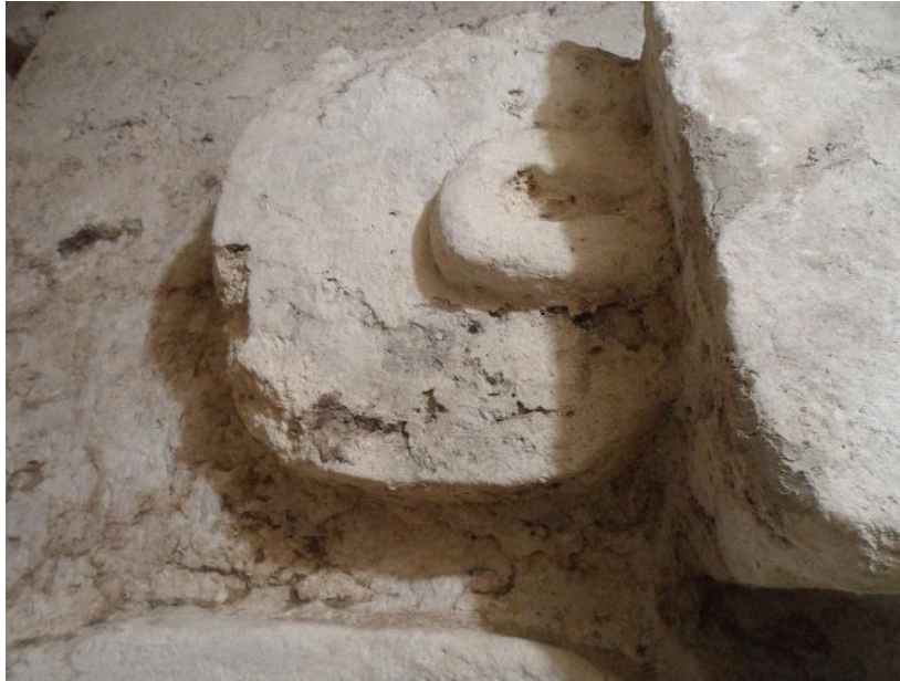
Figura 5.33. Abrasión en el estuco, se efectuó un proceso de limpieza mecánica en seco, se consolidaron los bordes y resanaron las oquedades con cal y arena al 2:1. Foto Edwin Pérez, 2019.
