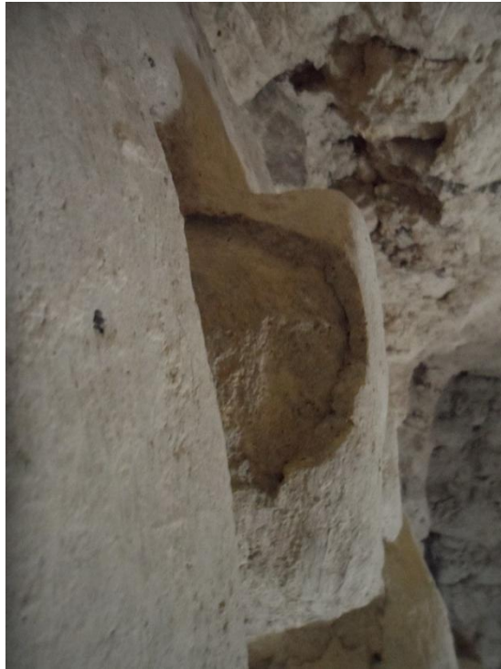
Figura 5.6. Área con bordes expuestos, con la limpieza efectuada previa a consolidación de bordes. Estructura M7-1 (Foto E. Pérez 2019).
