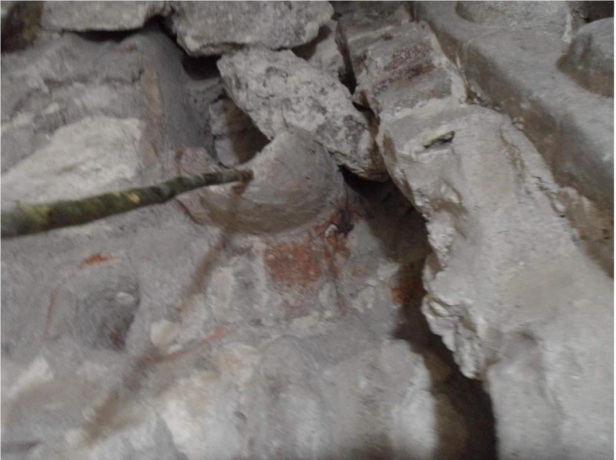
Figura 5.21. Fotografía que muestra el elemento colocado en su lugar con el recubrimiento de estuco, la varilla de soporte se dejó ubicada en el lugar hasta que el estuco había fraguado. Foto E. Pérez 2019.
