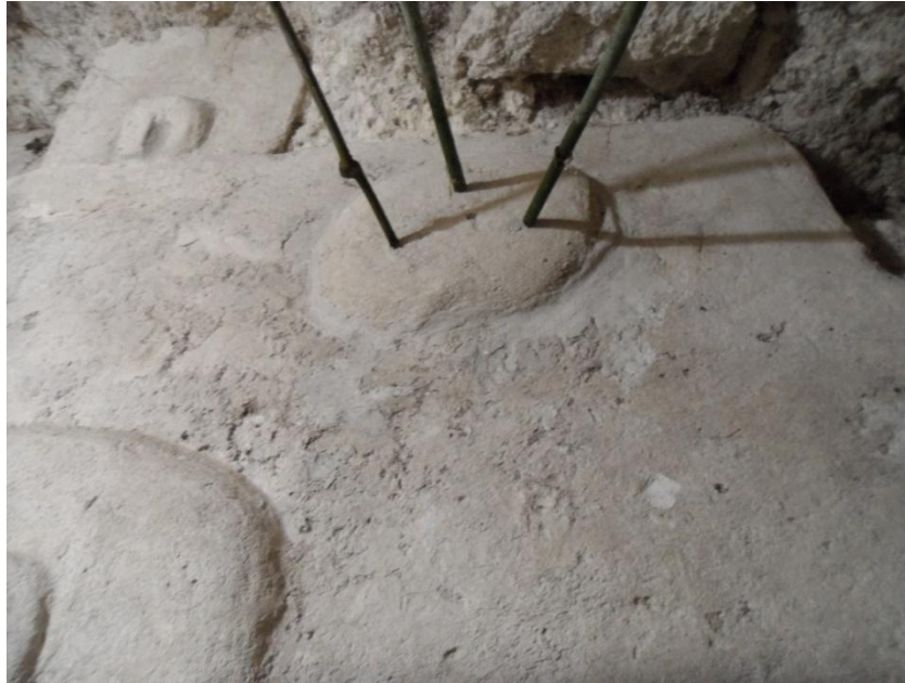
Figura 5.31. Fotografía que muestra el elemento adherido, apoyado con varillas para mantener la fuerza uniforme en el proceso de fraguado. La proporción del adhesivo en cal en arena cernida 1:1 Foto Edwin Pérez, 2019.
