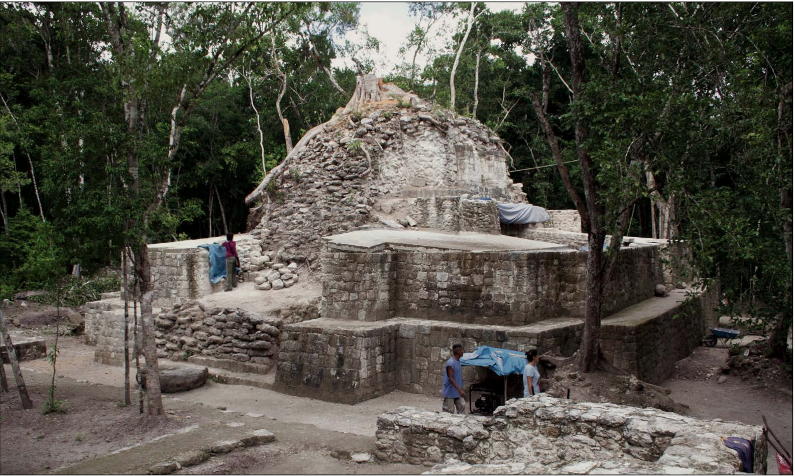
Figura 3. Vista de la Estructura 1 tras su consolidación inicial en 2006. Foto: Simon Martin/PAC.
