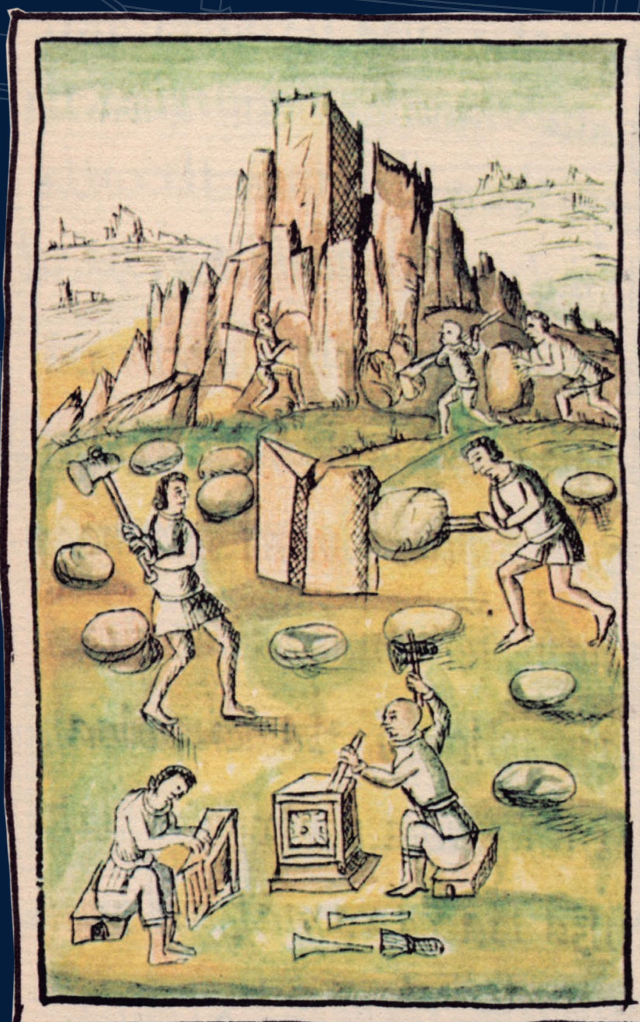
Explotación de la andesita de lamprobolita. Códice Florentino , lib. 10, 19v.
