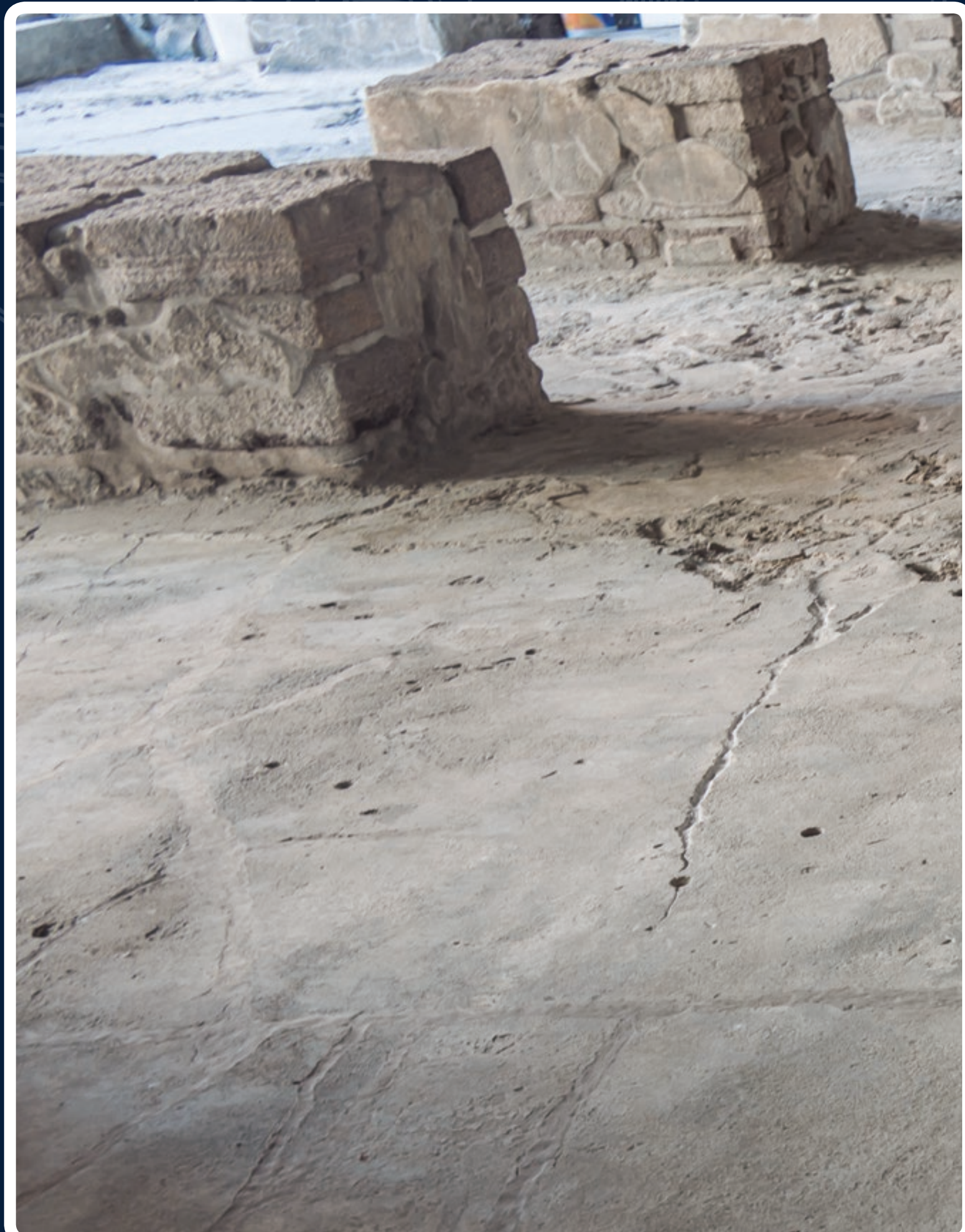
Estucos de recubrimiento elaborados con cal y arena. M. Islas, © PTM.
