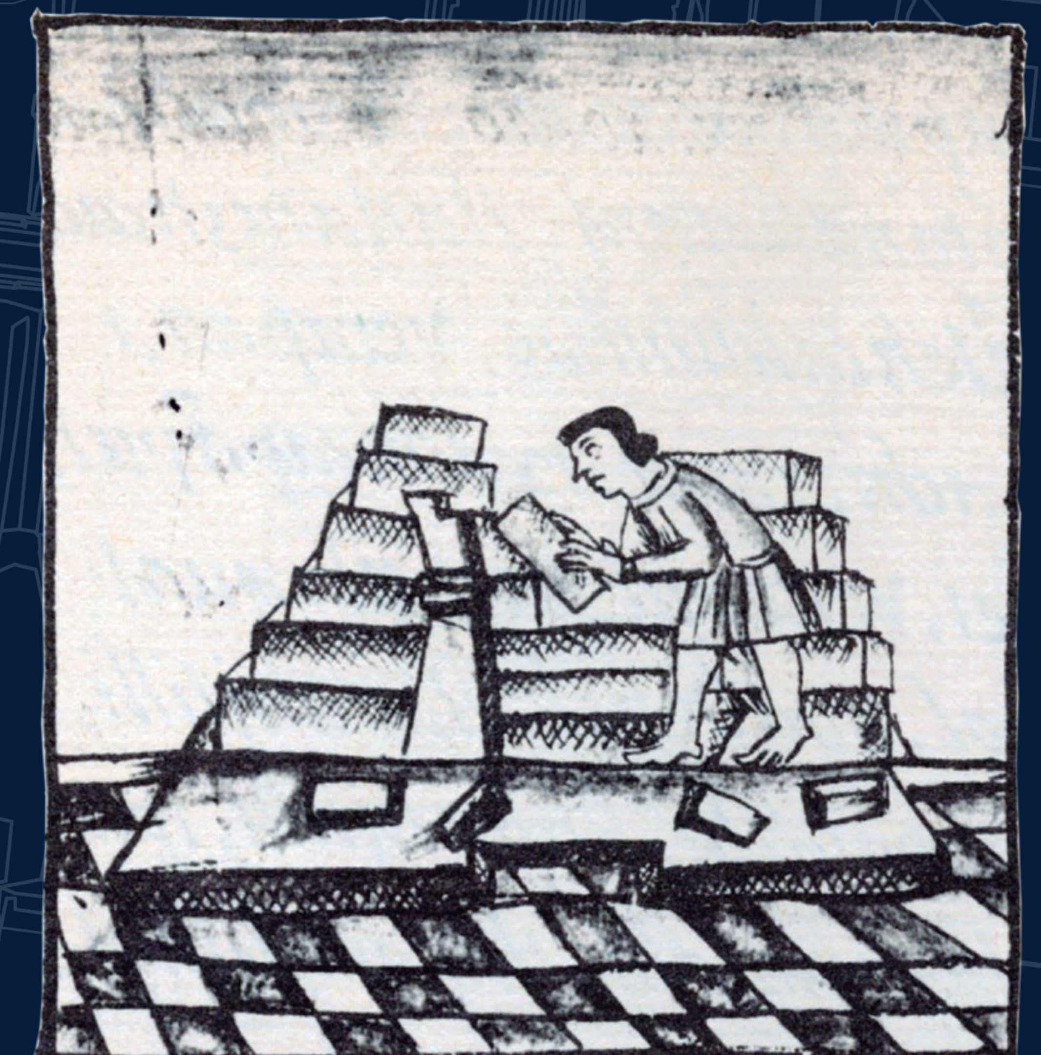
Sistema de sillería para paredes, taludes y escalinatas. Códice Florentino , lib. 11, 241r.
