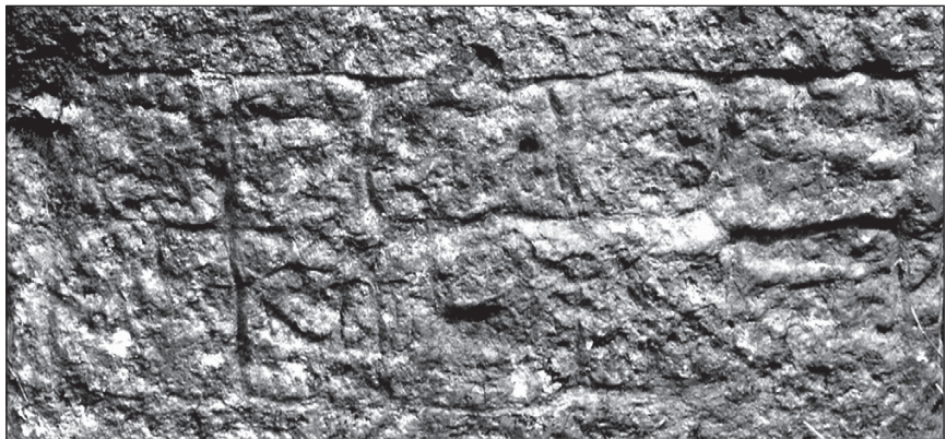
Pilar occidental Lado Oeste
