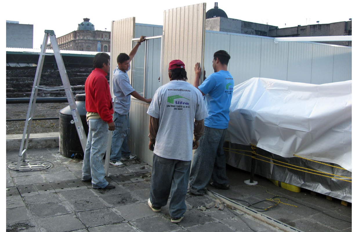
FIGURA 167. Proceso de desarmado de la caseta-laboratorio de multipanel (MVC).
