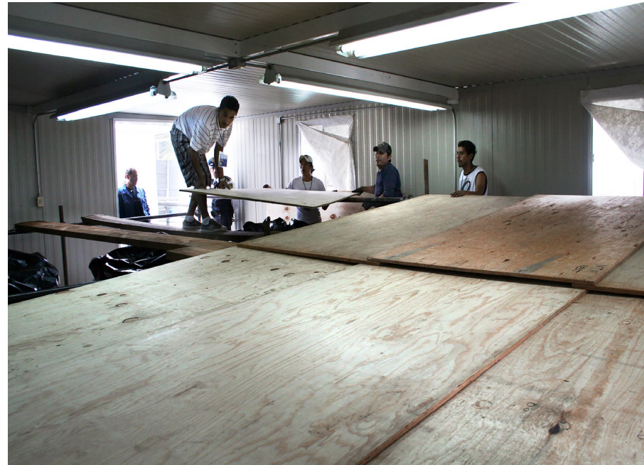
FIGURA 165. Tablones de madera de pino y hojas de triplay sobre la estructura tubular (FCM).
