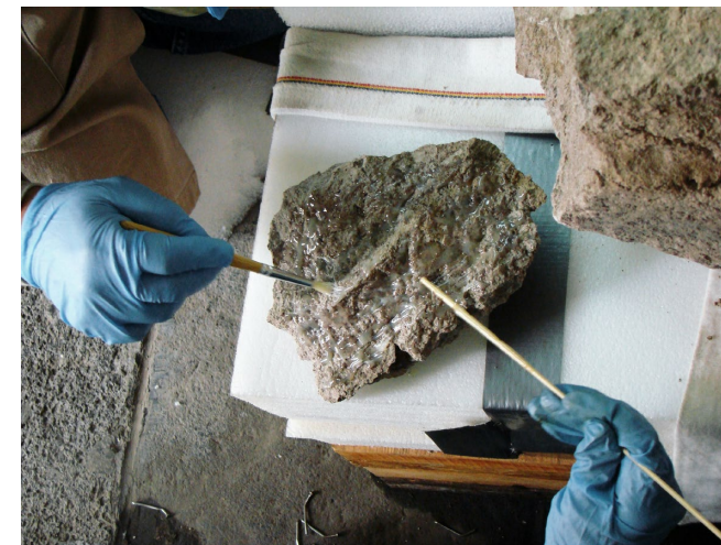
FIGURA 85. Aplicación de resina epóxica para la unión de fragmentos (CBM).
