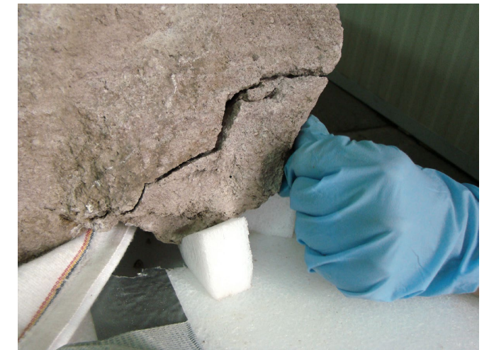
FIGURA 86. Proceso de unión con resina epóxica (CML).
