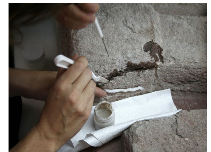
FIGURA 92. Pruebas de consolidación en zona con exfoliación (MBR).
