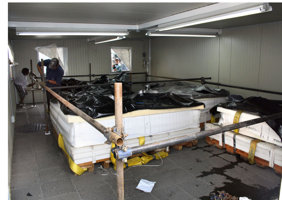
FIGURA 164. Estructura tubular alrededor de los cuatro fragmentos (FCM).
