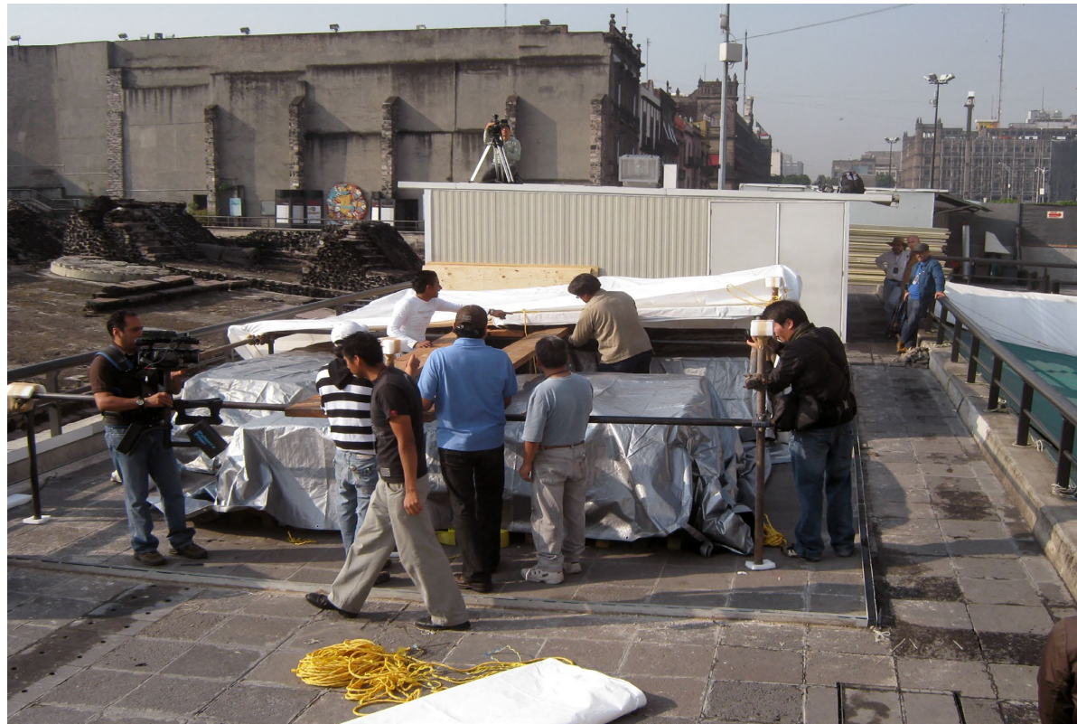
FIGURA 168. Desarmado de estructura tubular de protección (FCM).
