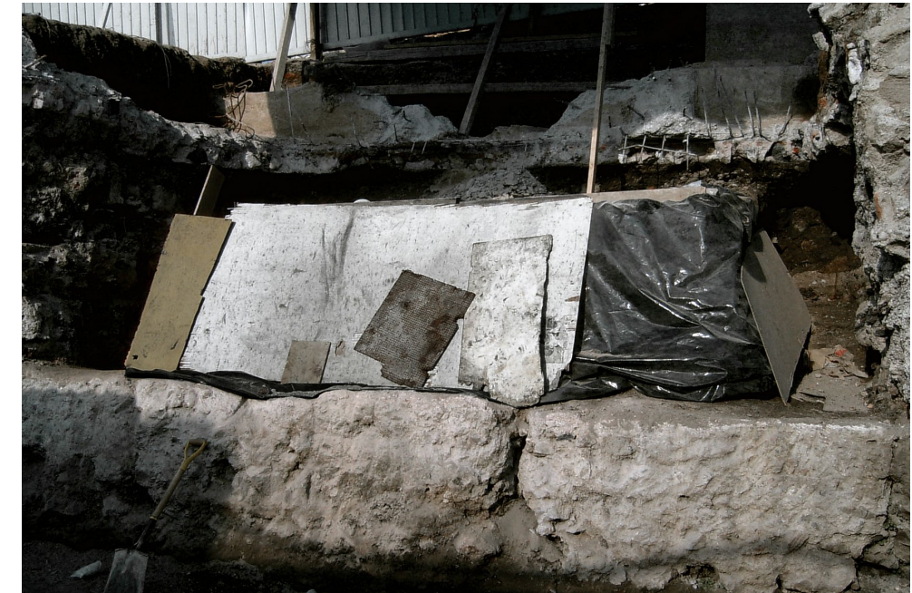
FIGURA 40. Coraza de protección utilizada durante los trabajos de retiro (vpc).
