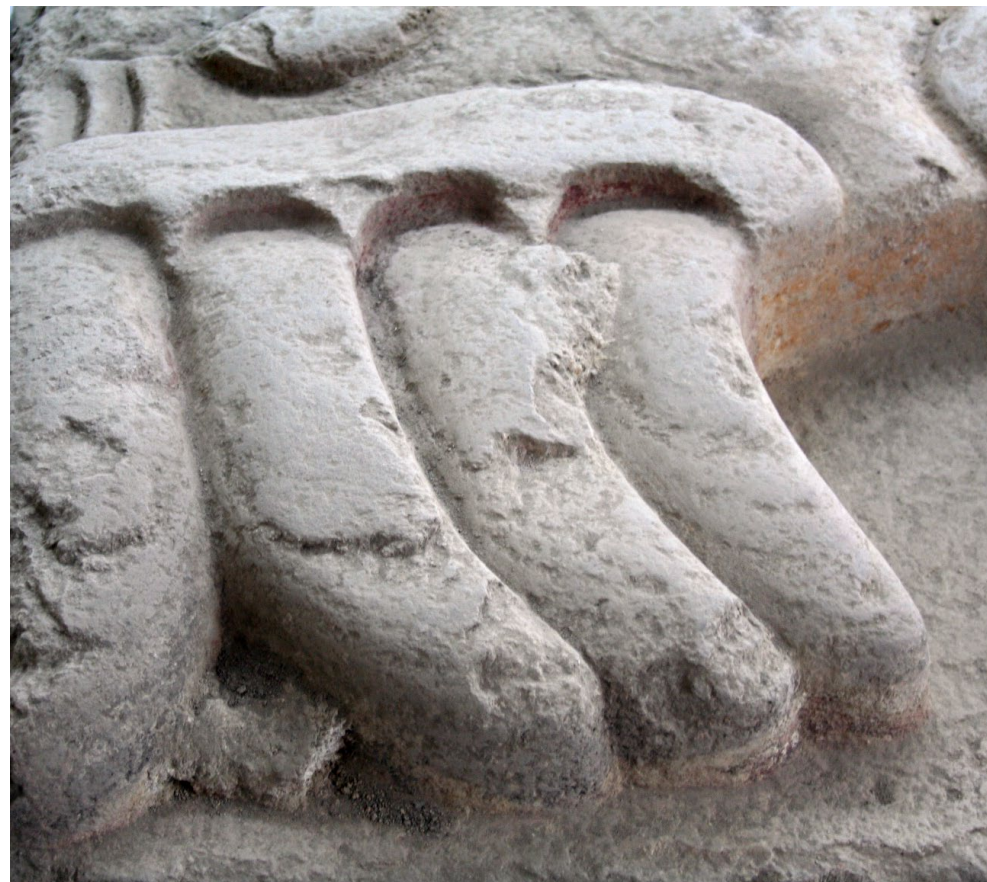
FIGURA 62. Detalle. Deterioros estructurales en fragmento B (MBR).
