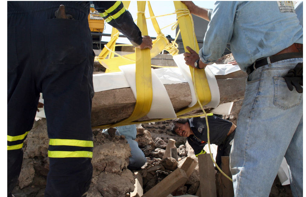
FIGURA 54. Revisión de los apoyos antes del levantamiento (JMG).
