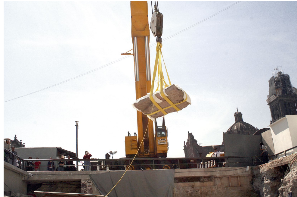
FIGURA 56. Vista general de la grúa con el fragmento (JMG).
