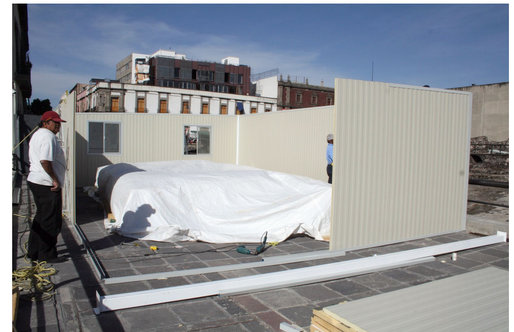
FIGURA 59. Construcción de la caseta de multipanel para resguardar los fragmentos (LLL).
