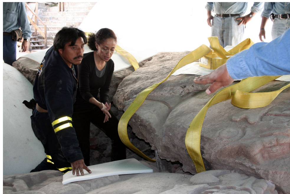
FIGURA 53. Definición de los puntos de apoyo para las eslingas (JMG).
