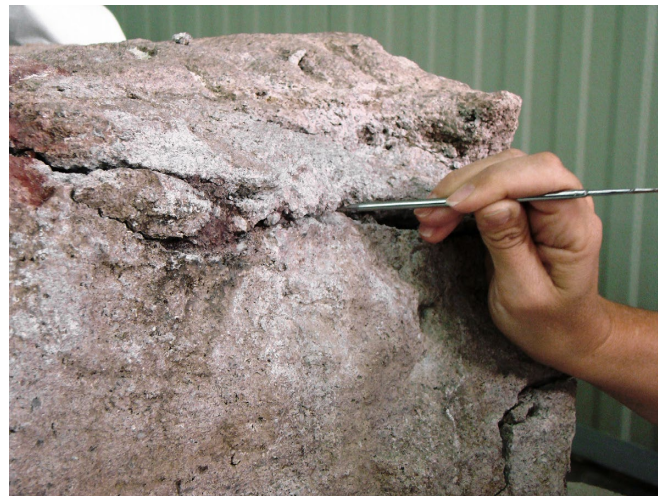
FIGURA 78. Extracción de tierra dentro de la grieta en el fragmento D (CML).
