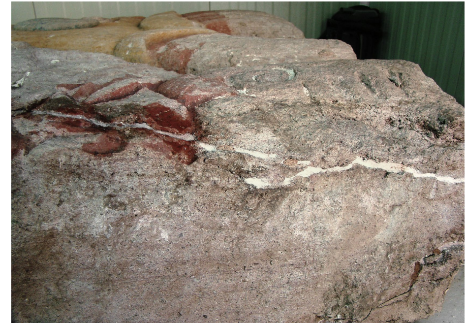
FIGURA 80. Grieta resanada (CBM).
