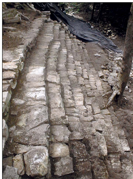
Figura 26. El proceso de restauración de la escalinata corrida en el primer cuerpo del basamento: (a) una vez libre de escombros; (b) una vez colocadas las lajas. Archivo del Proyecto Grupo de las Cruces.
