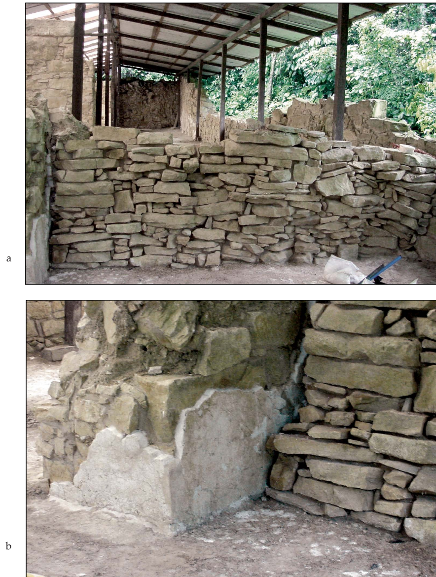
Figura 40. El muro seco construido probablemente en la etapa posdinástica: (a) vista general; (b) detalle de su desplante. Archivo del Proyecto Grupo de las Cruces.
