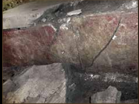
Figura 85. Tablero sur del trono quebrado por el colapso del edificio. Archivo del Proyecto Grupo de las Cruces.
