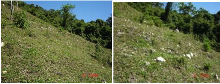
Fig. 8. 3 Imágenes de la pendiente y terraza G22; vista desde el Sur.
