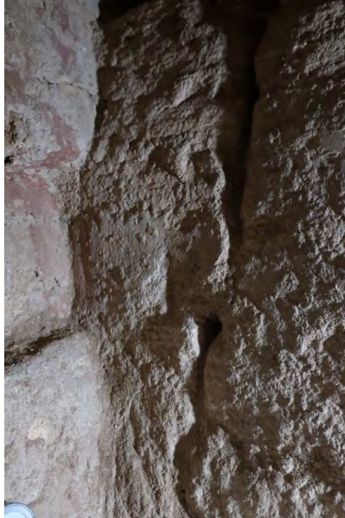
Figura 1.1. 7. Unificación de la Adosada M13-1 con estructura principal – parche en forma de “V”, (fotografía O. Navarro-Farr 2025).
