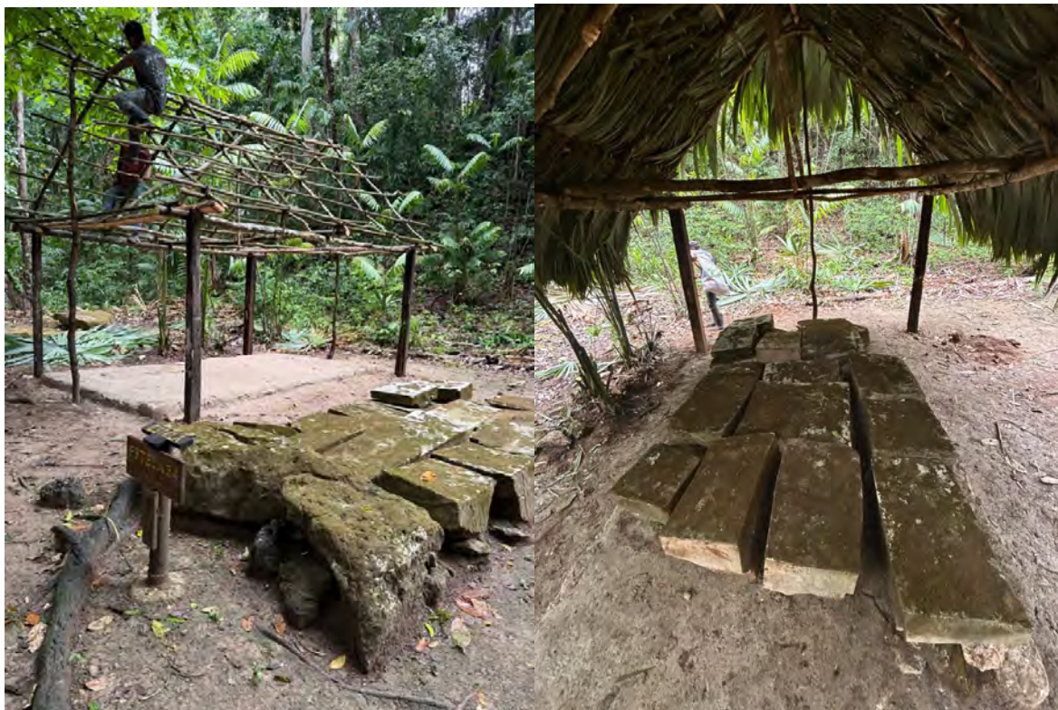
Figura 2.3. 4. Proceso de construcción de la plataforma y el techo de la Estela 34, (fotografía S. Berenson 2025).
