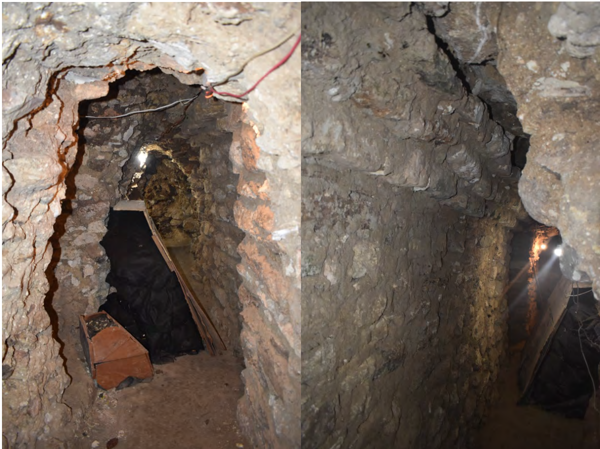
Figura 1.1. 2. Proceso de consolidación en muro este de túnel principal, (fotografía D. Del Cid 2025).
