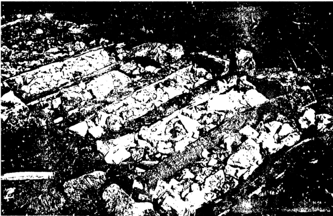
Figura 2a Andador construido con piedra irregular, en un terreno plano cenagoso Figura 2b Entarimado de troncos relleno con balastre, especial para caminos que ascienden
