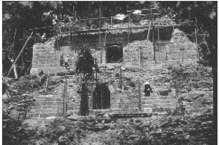
Proceso de consolidación del templo superior
