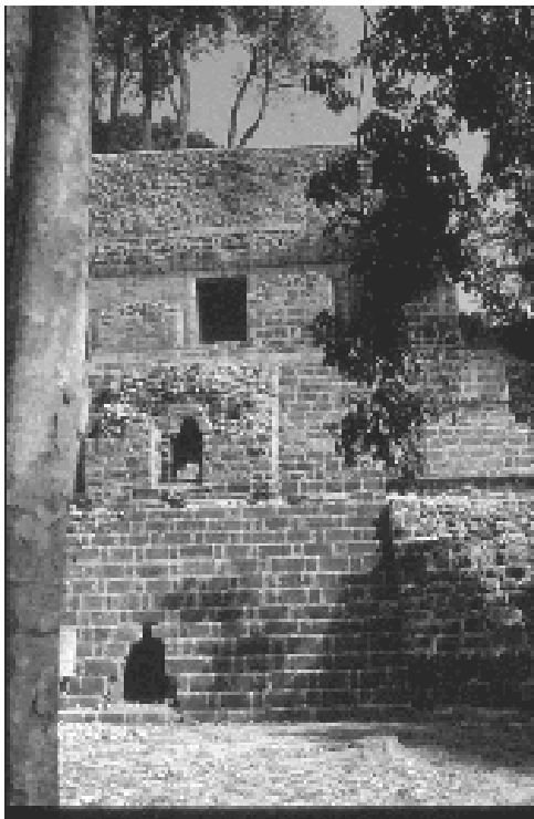
Vista del frente de la estructura consolidada
