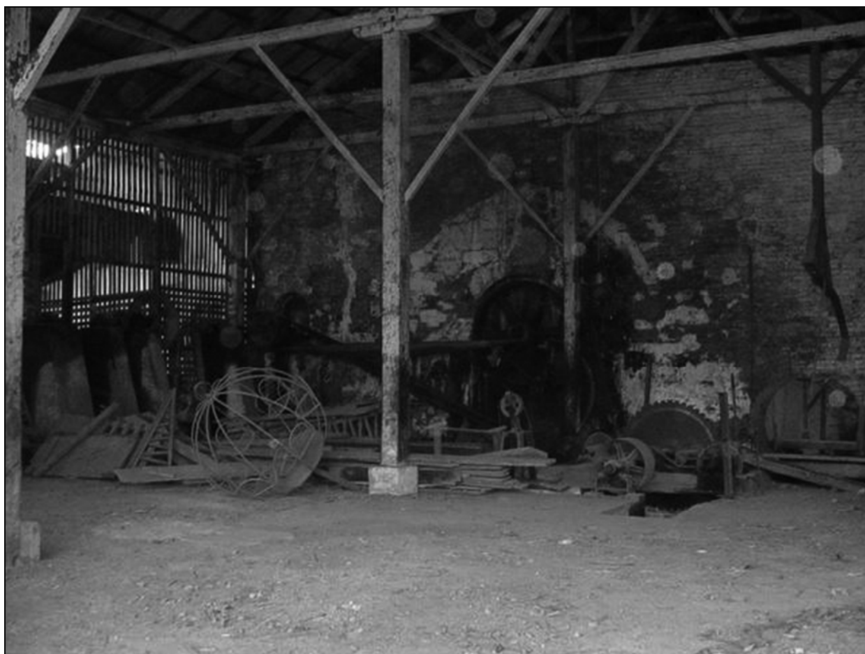
Figura 9 Rueda Pelton que acciona los ejes de poleas que funciona con energía hidráulica
