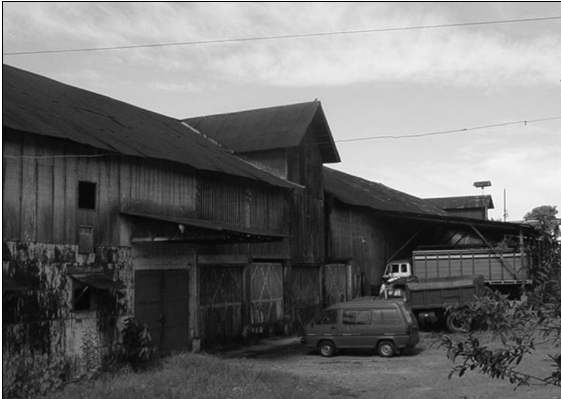
Figura 5 Fachada del Taller de Máquinas
