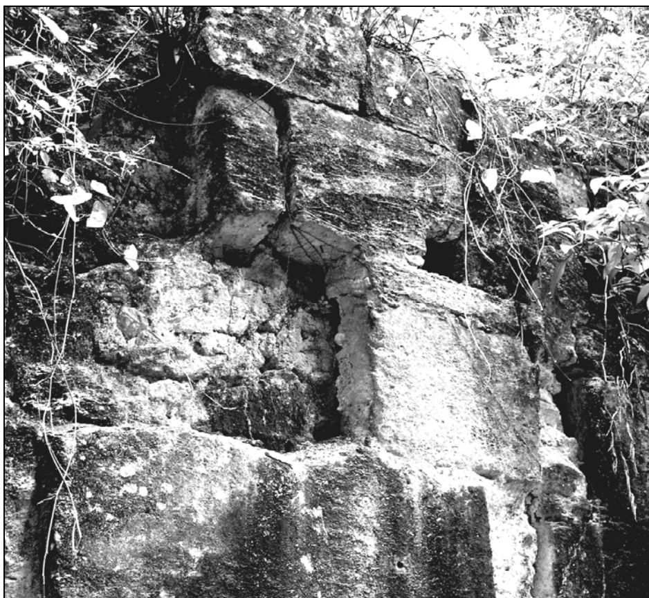
Figura 4 Sillares de los muros de la Acrópolis
