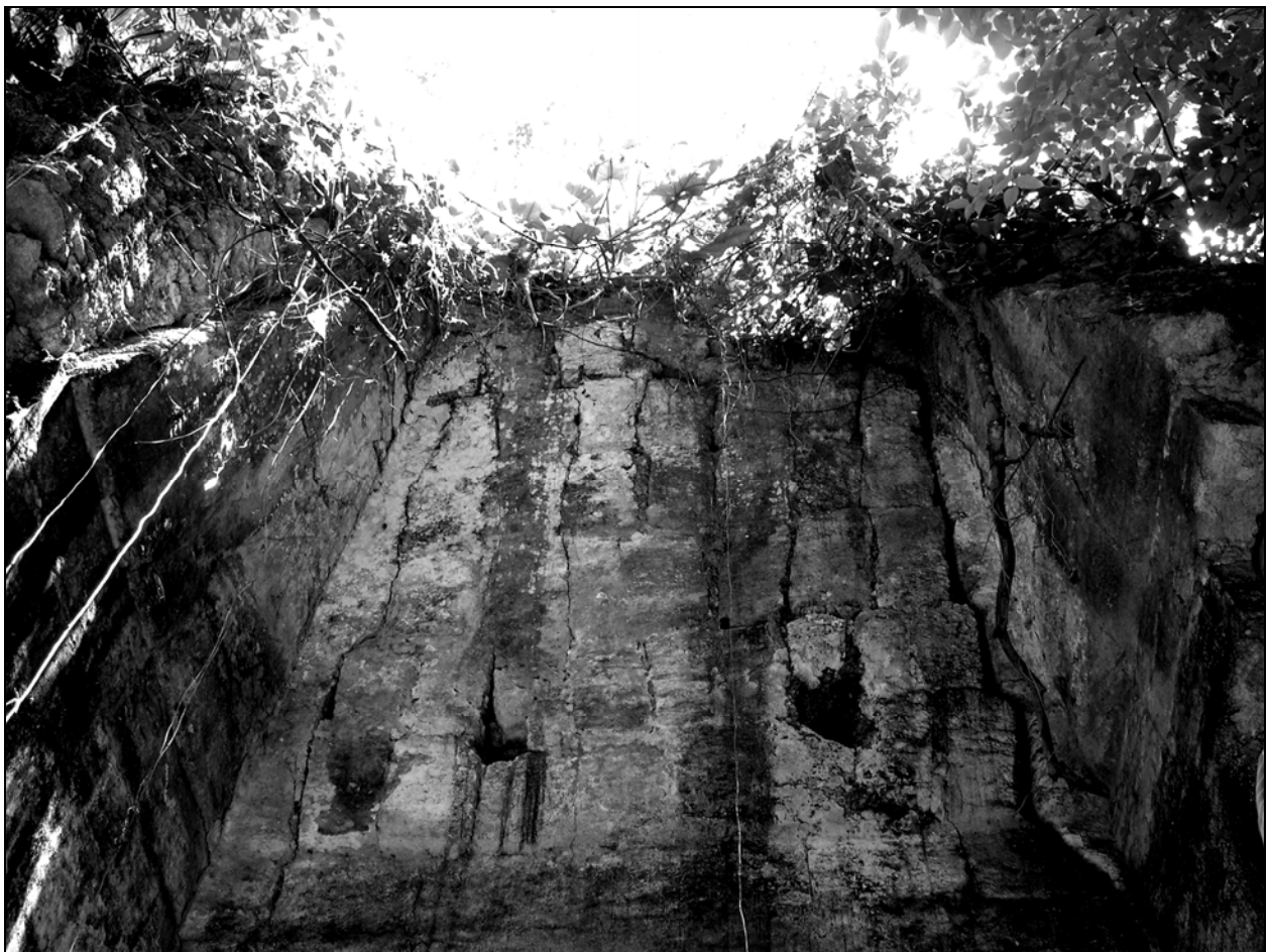
Figura 8 Bóveda de una de las edificaciones de la Acrópolis en su estado actual
