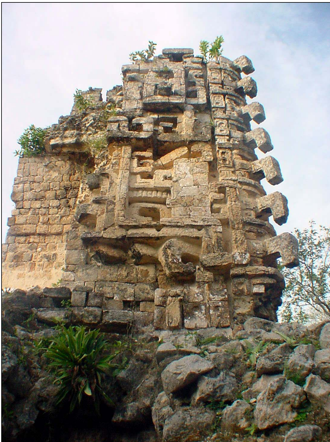
Figura 2 Estructura I antes de la intervención
