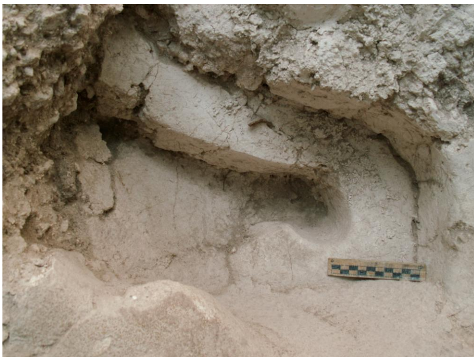
Figura 2 Estado general del panel central y detalle en voluta que muestra material de arrastre, desprendimientos y raíces
