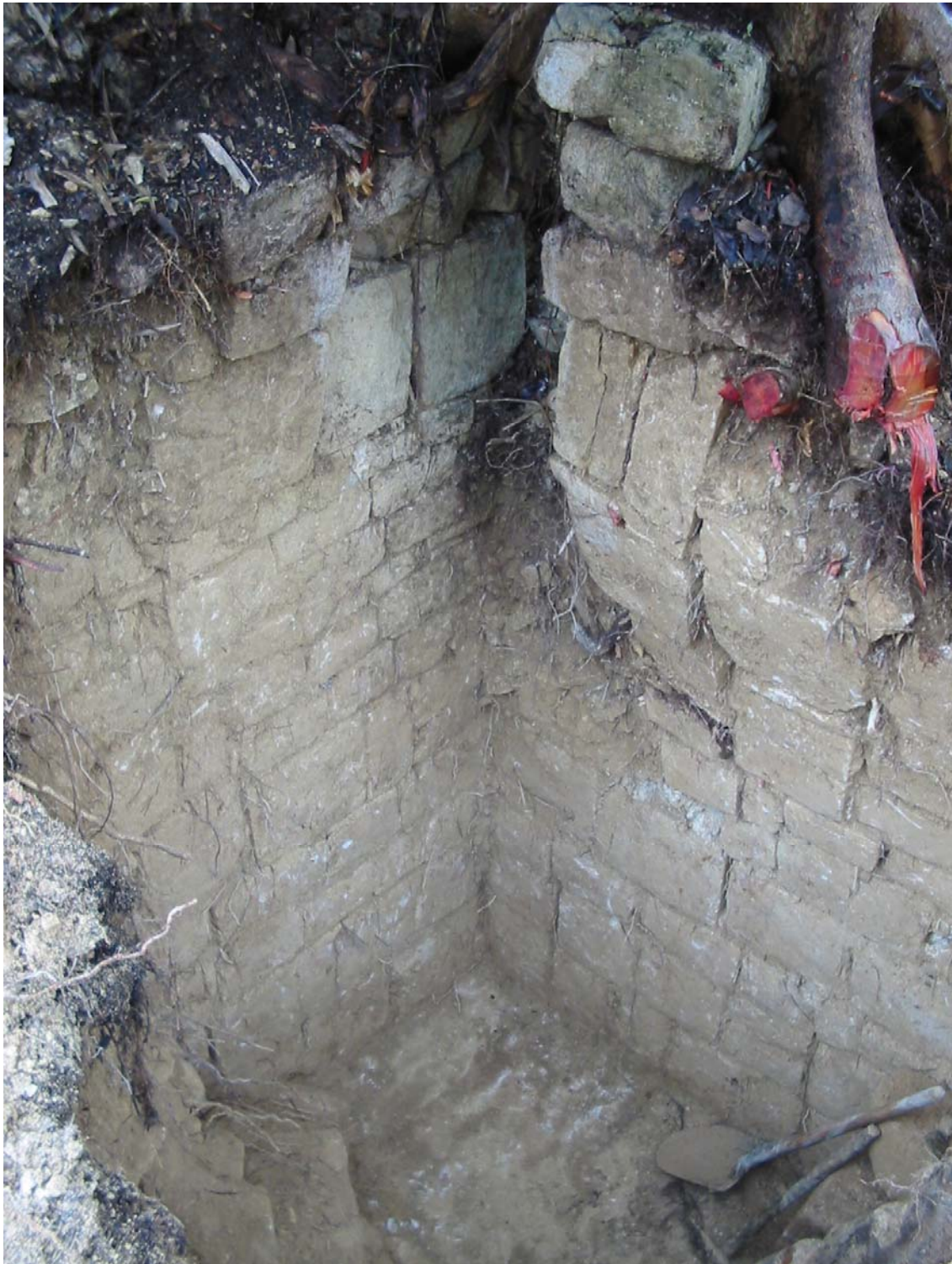
Figura 26 Detalle en Estructura Norte
