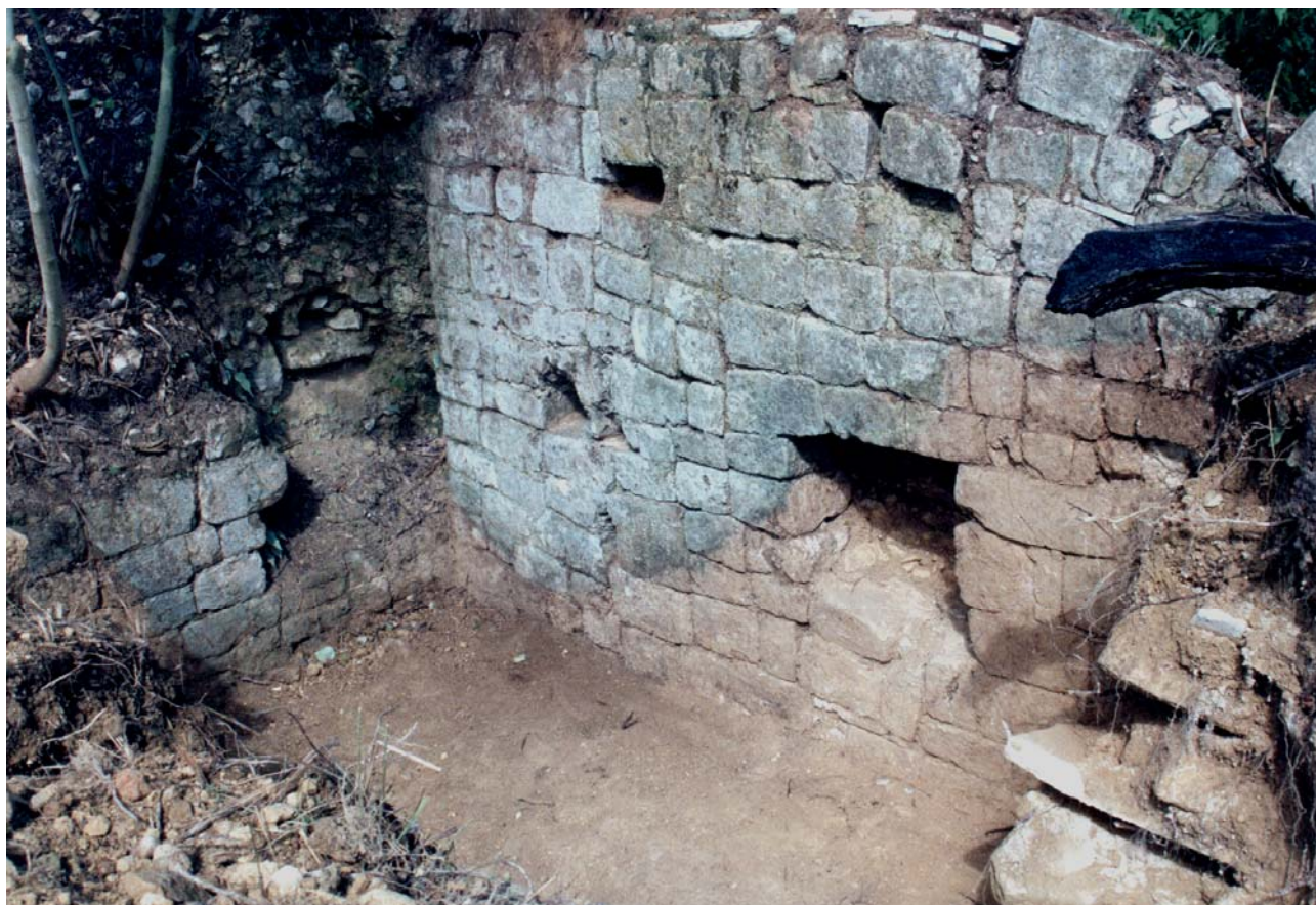
Figura 27 Detalle en Estructura Norte
