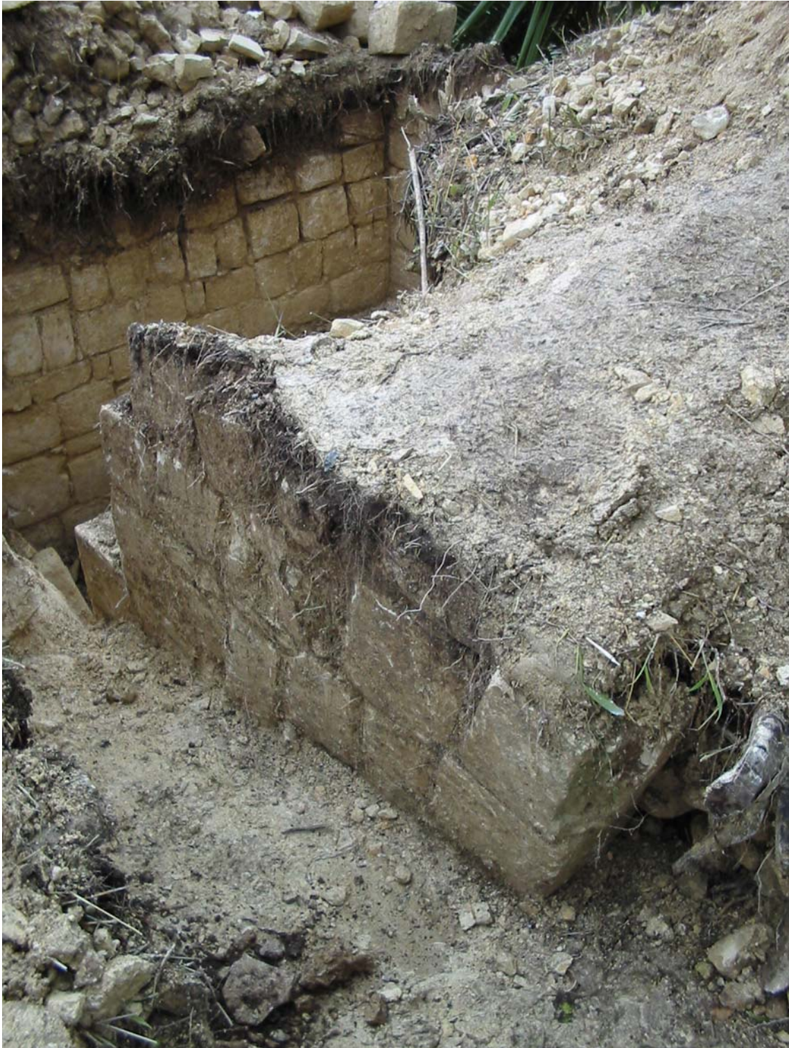
Figura 25 Detalle en Estructura Norte
