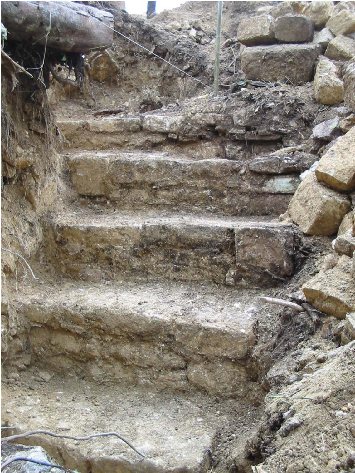
Figura 19 Detalle de Estructura Sur
