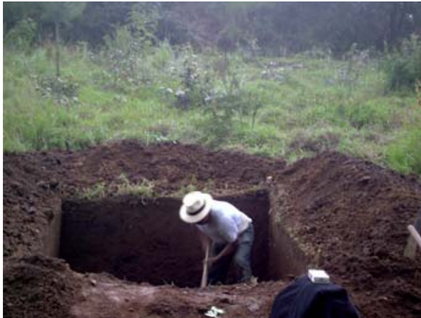
Figura 4 Proceso de excavación
