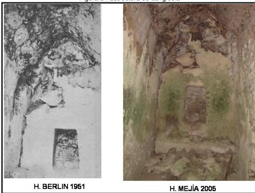
Figura 25 Interior de estructura en La Iglesia
