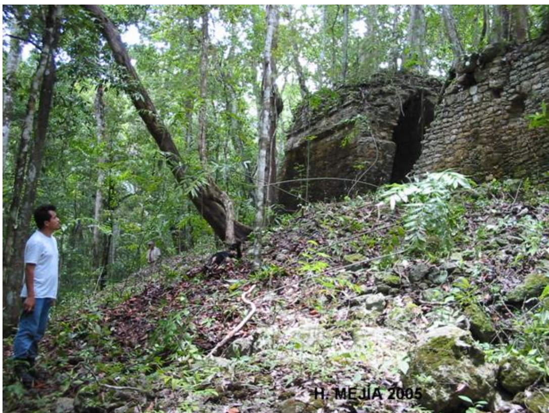
Figura 24 Estructura de La Iglesia
