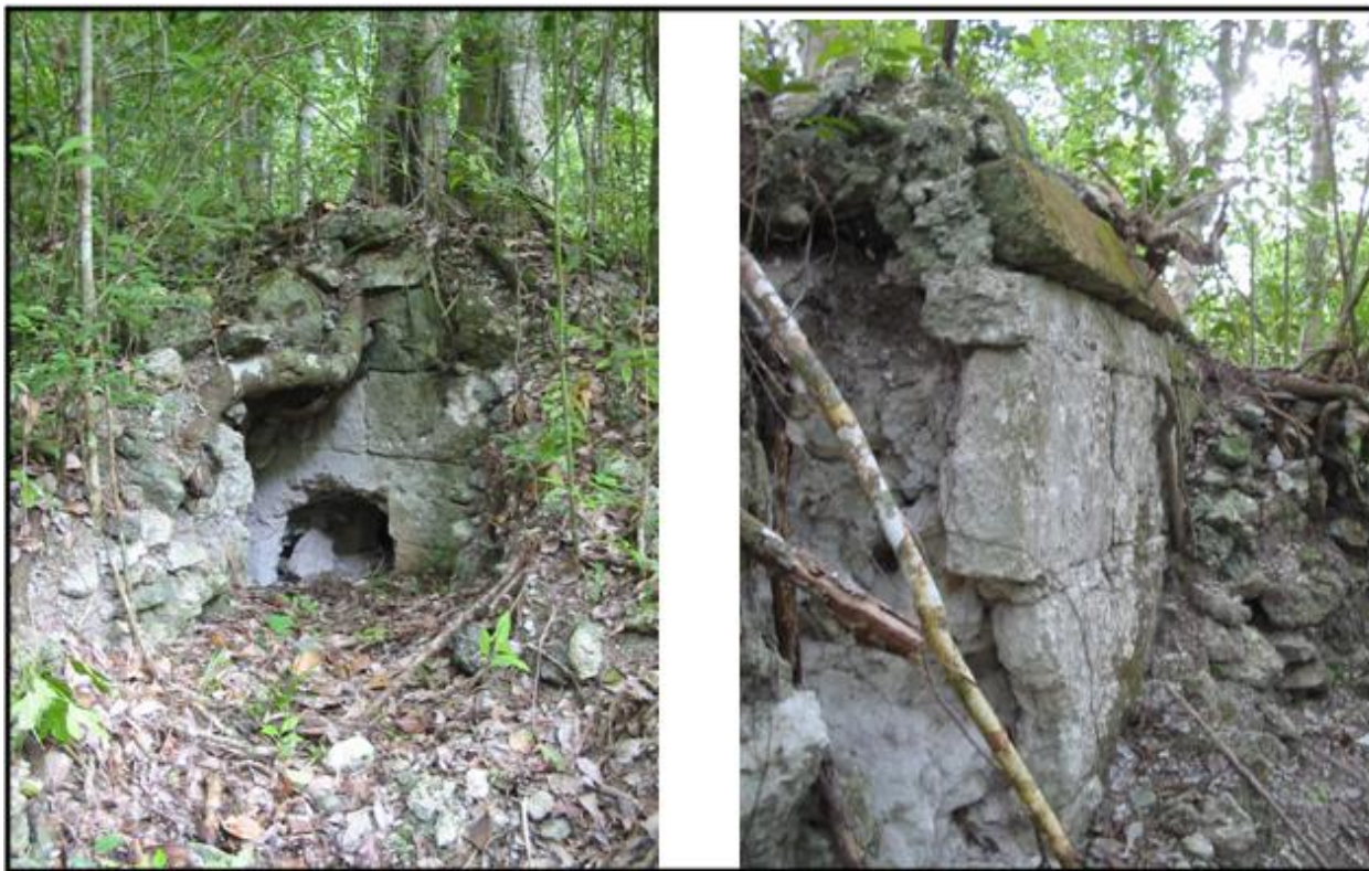
Figura 27 Detalle de estructura en La Sarteneja
