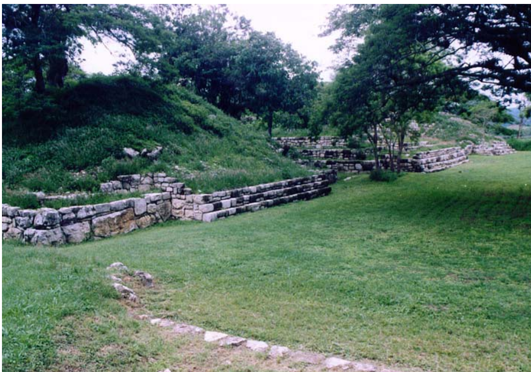
Figura 9 Basamento del lado Norte
