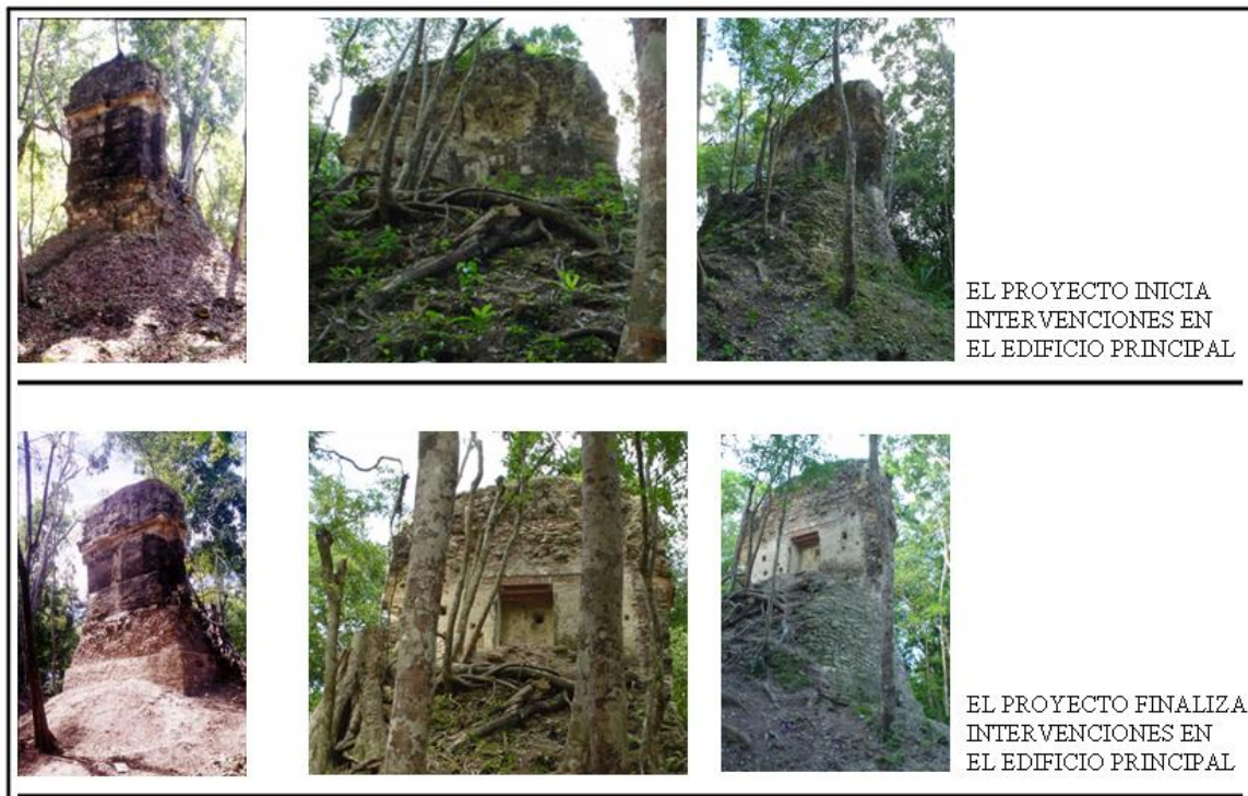
Figura 11 Programa de rescate en Corozal Torre
