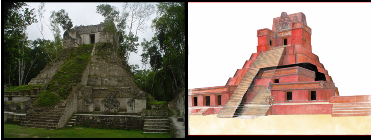
Figura 11 Edificio E de Nakum
