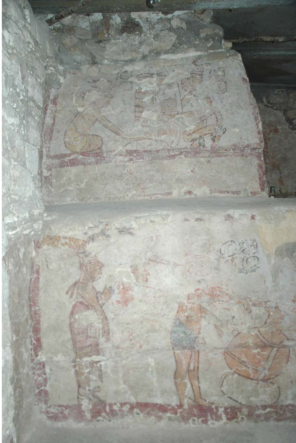
Figura 2 La primera fase pictórica se encuentra muy deteriorada en la esquina Suroeste, Primer Cuerpo, Frente Este (según fotografía del Proyecto Calakmul)
