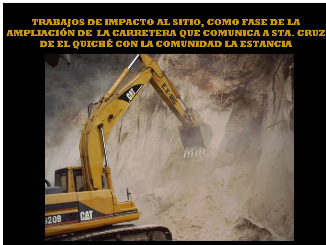
Figura 7 Ampliación de la carretera
