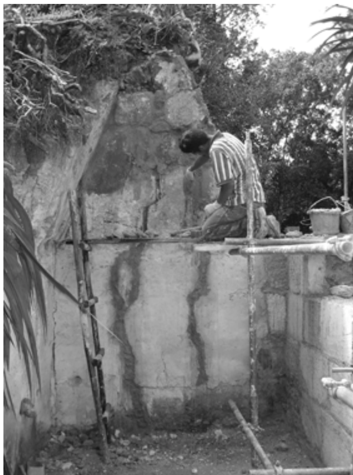
Figura 7 Consolidación de muros, Edificio Q
