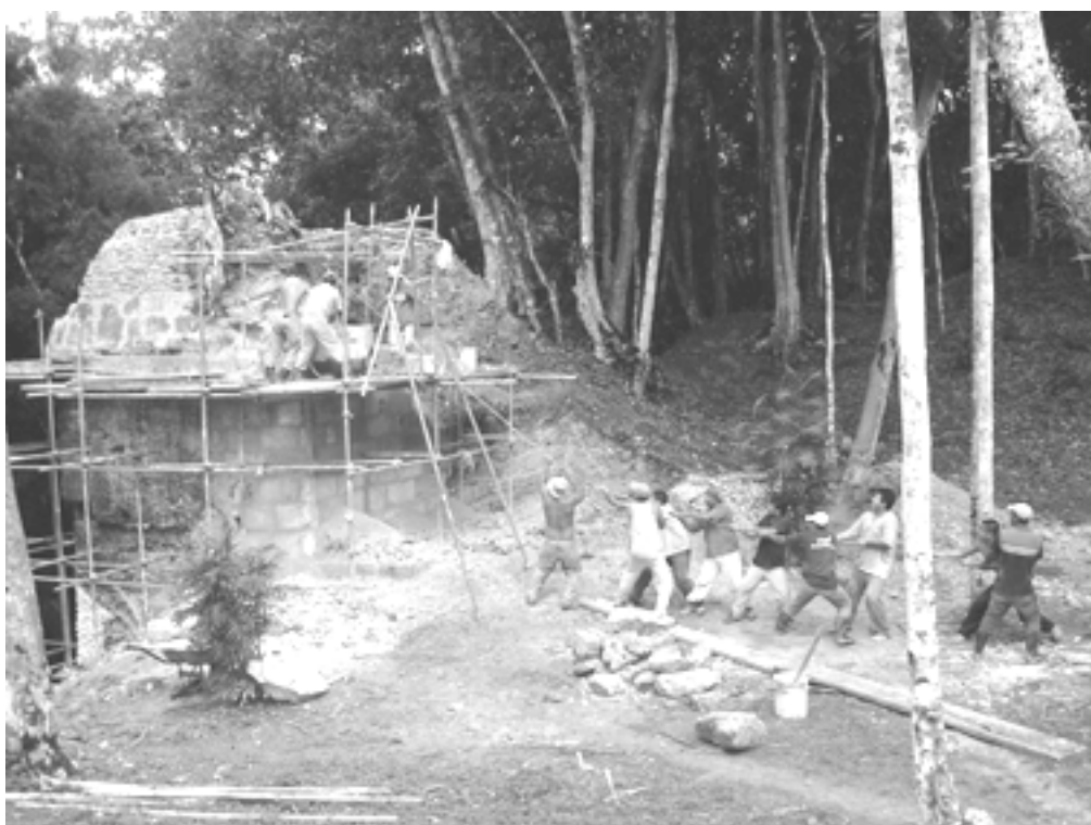
Figura 6 Integración de esquinero suroriente del Edificio M
