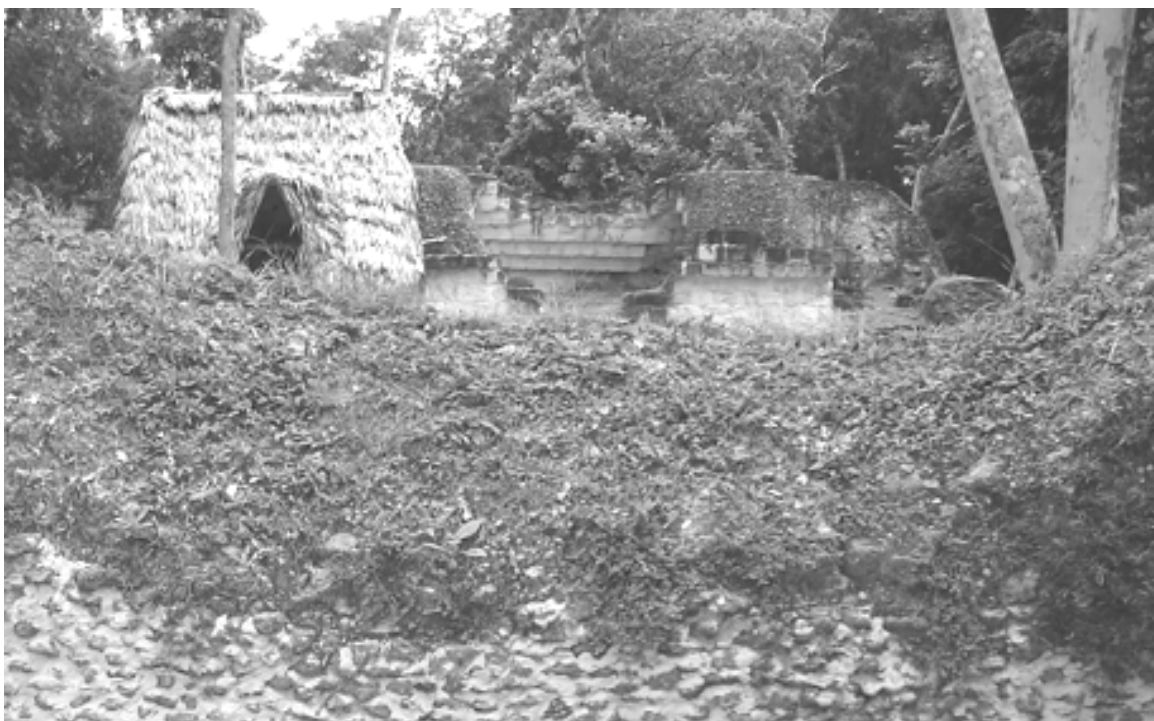
Figura 1 Cubierta reversible en cámara de Edificio R
