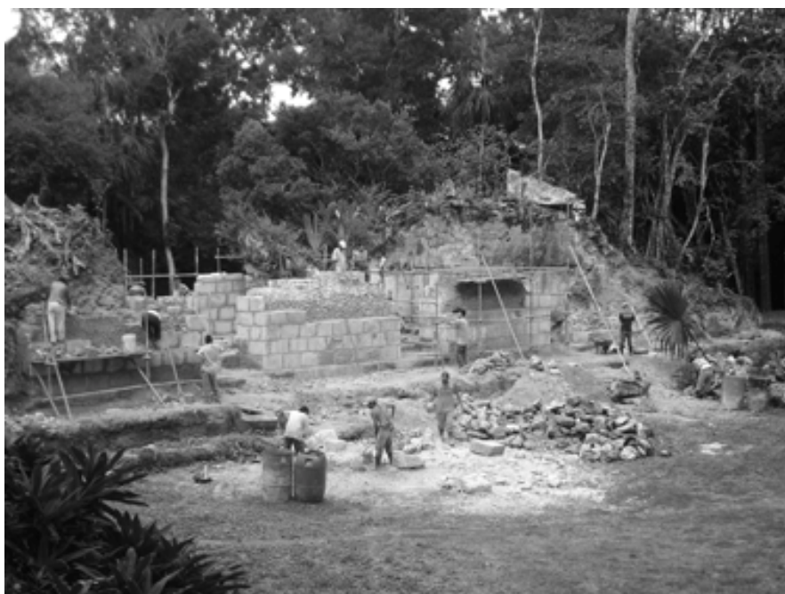
Figura 8 Restauración del sector poniente, Edificio Q
