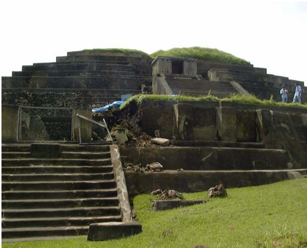
Figura 11 Colapso del Edificio de las Columnas en 2002
