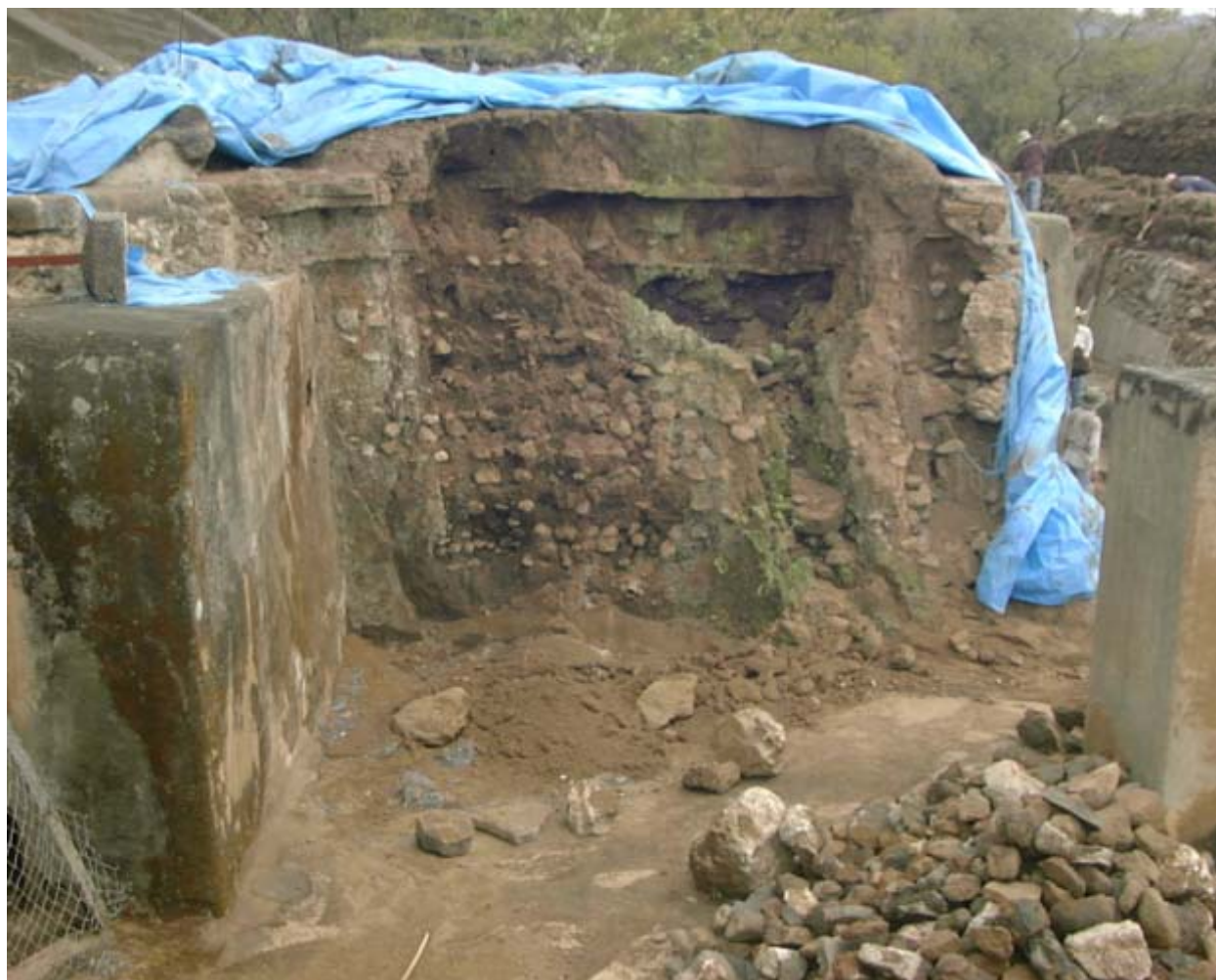
Figura 13 Colapso del Edificio de las Columnas en 2006
