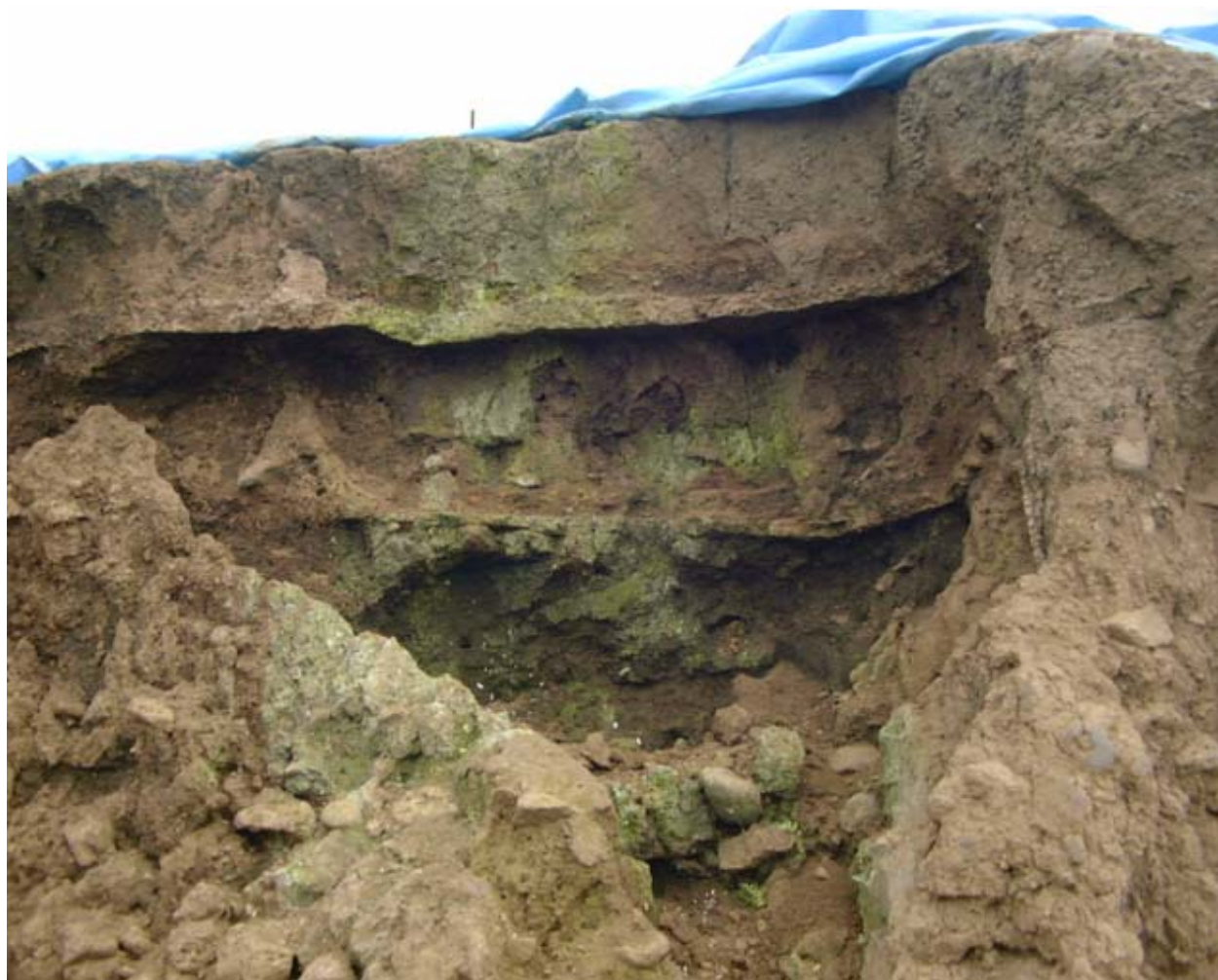
Figura 14 Colapso del Edificio de las Columnas en 2006
