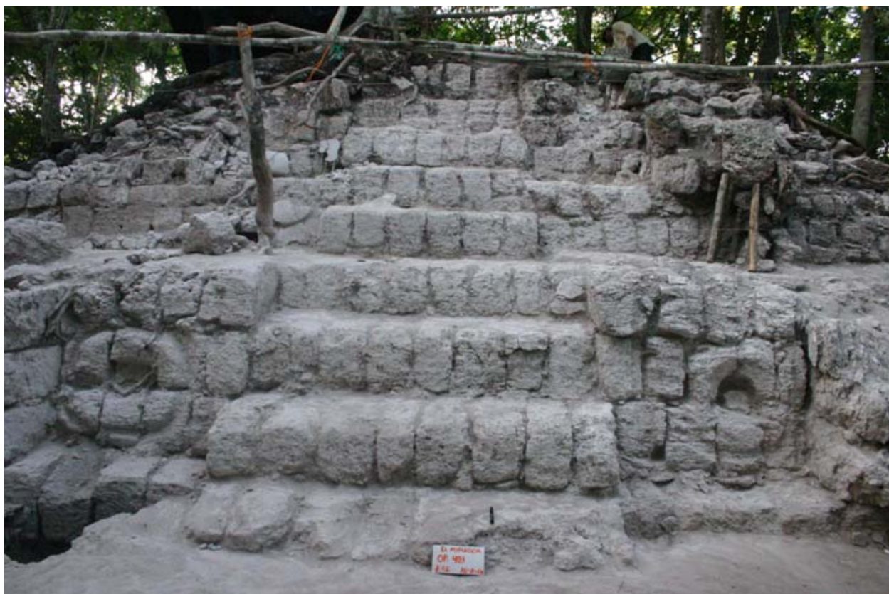
Figura 5 Escalinata central de Edificio 2A6-6
