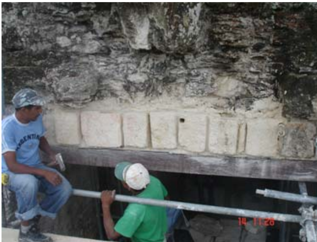
Figura 20 Templo IV, cambio de vigas del dintel
