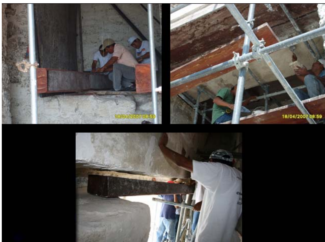
Figura 21 Templo IV, labrando y cambiando vigas
