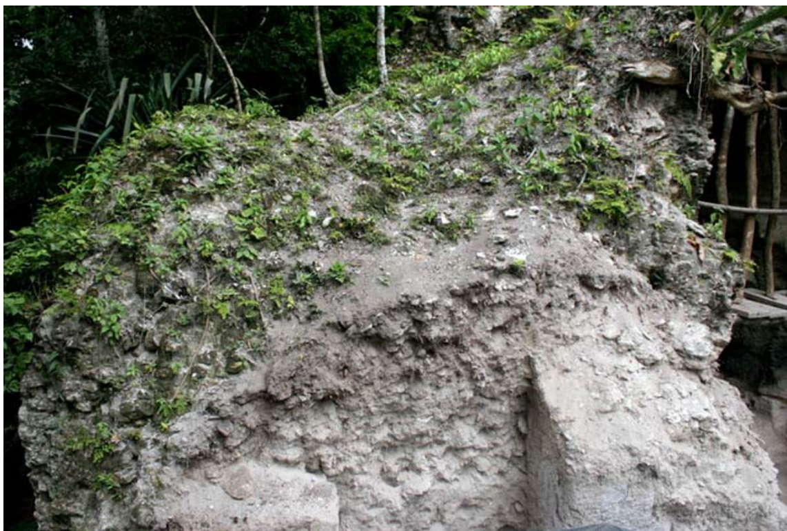
Figura 13 Condición de los edificios
