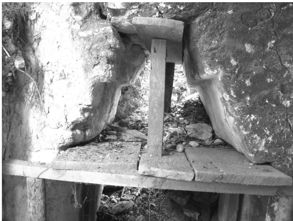
Figura 8 Detalle de bóveda con forma de “escalera invertida” de la cámara sur
