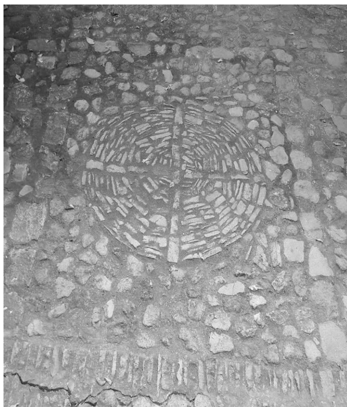
Figura 8 Empedrado que utiliza la técnica mixta
