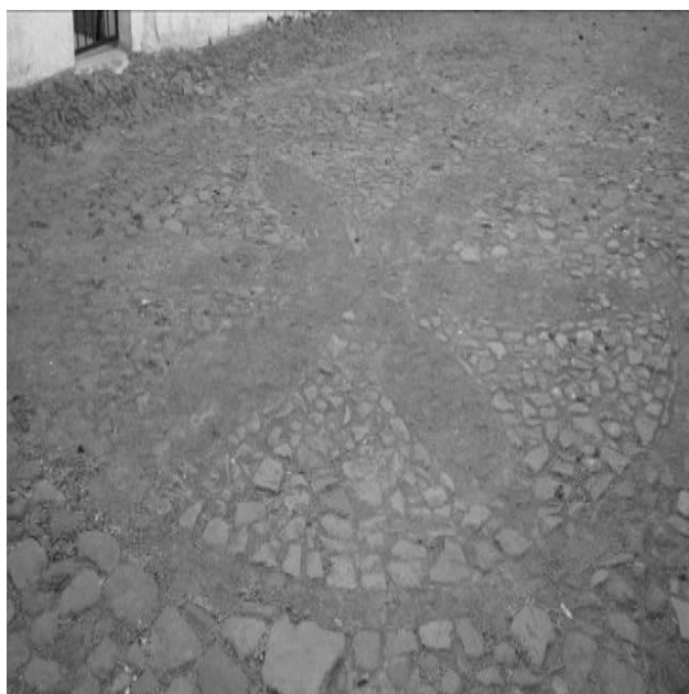
Figura 6 Ejemplo de empedrado de lineal o de cala
