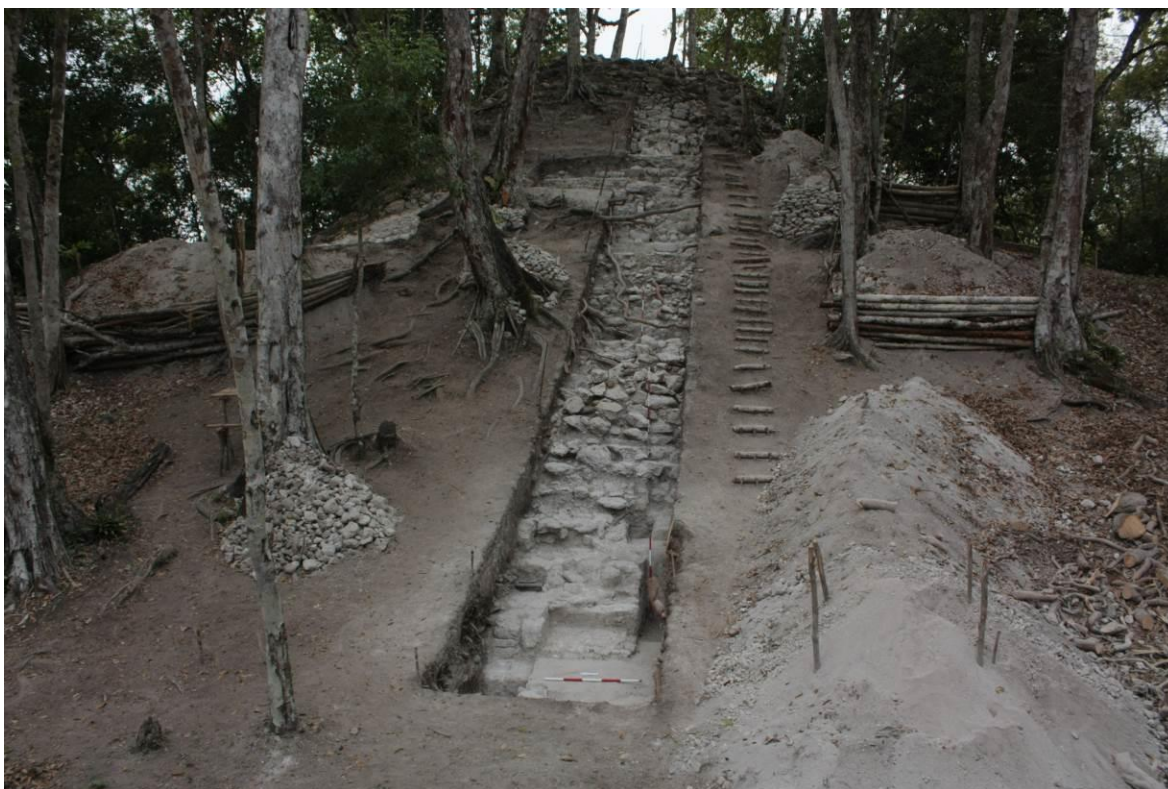
Figura 2. Estructura H-I trinchera sobre fachada oeste.
