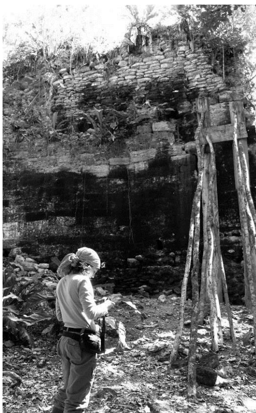
Figura 6. Fachada Edificio 1 en Tzikin Tzakan
