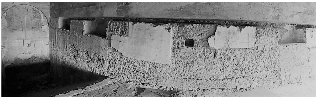
Fig.9. Vista interior del paramento norte del arco de Santa Catalina. Foto: O. de la Maza.
