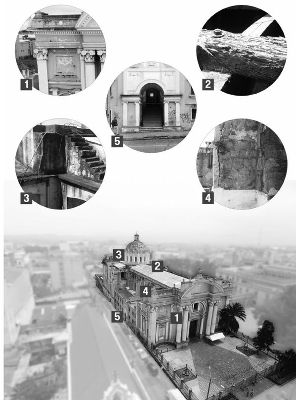
Figura 4. Daños y alteraciones en Fachadas Noroeste. Dibujo por D. Aguilar y fotografía por J. Aguilar.
