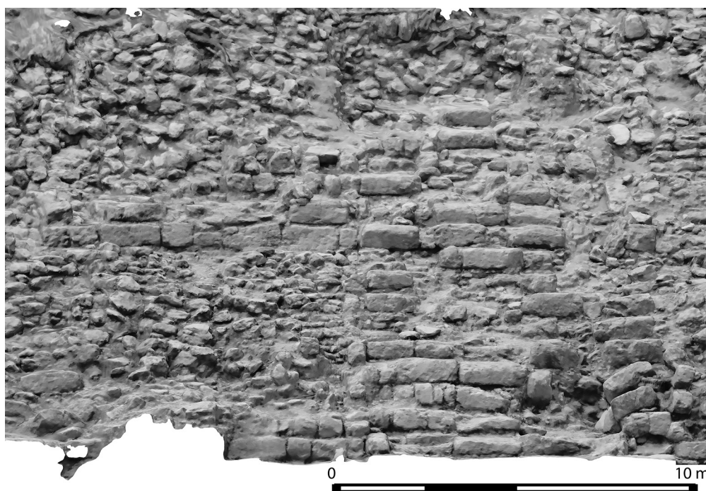
Figura 6. Ortofoto de elevación frontal y de planta en los que se resaltan detalles arquitectónicos de importancia para las intervenciones de restauración y la comprensión del edificio. Ortofoto: J. Marín, J. Guzmán© FARES.
