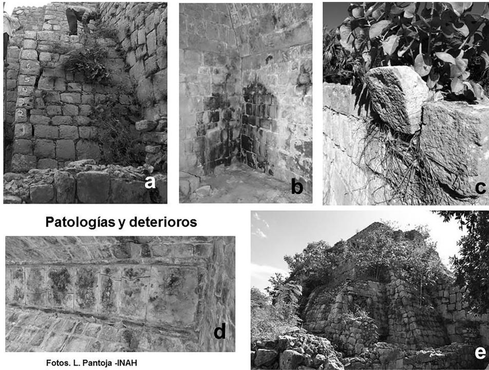
Figura 3. Ejemplificación de patologías y deterioros en el sitio Oxkintok. a) Grietas, b) humedades y filtraciones, c) desprendimientos, d) grietas y e) vegetación intrusiva. (L. Pantoja).
