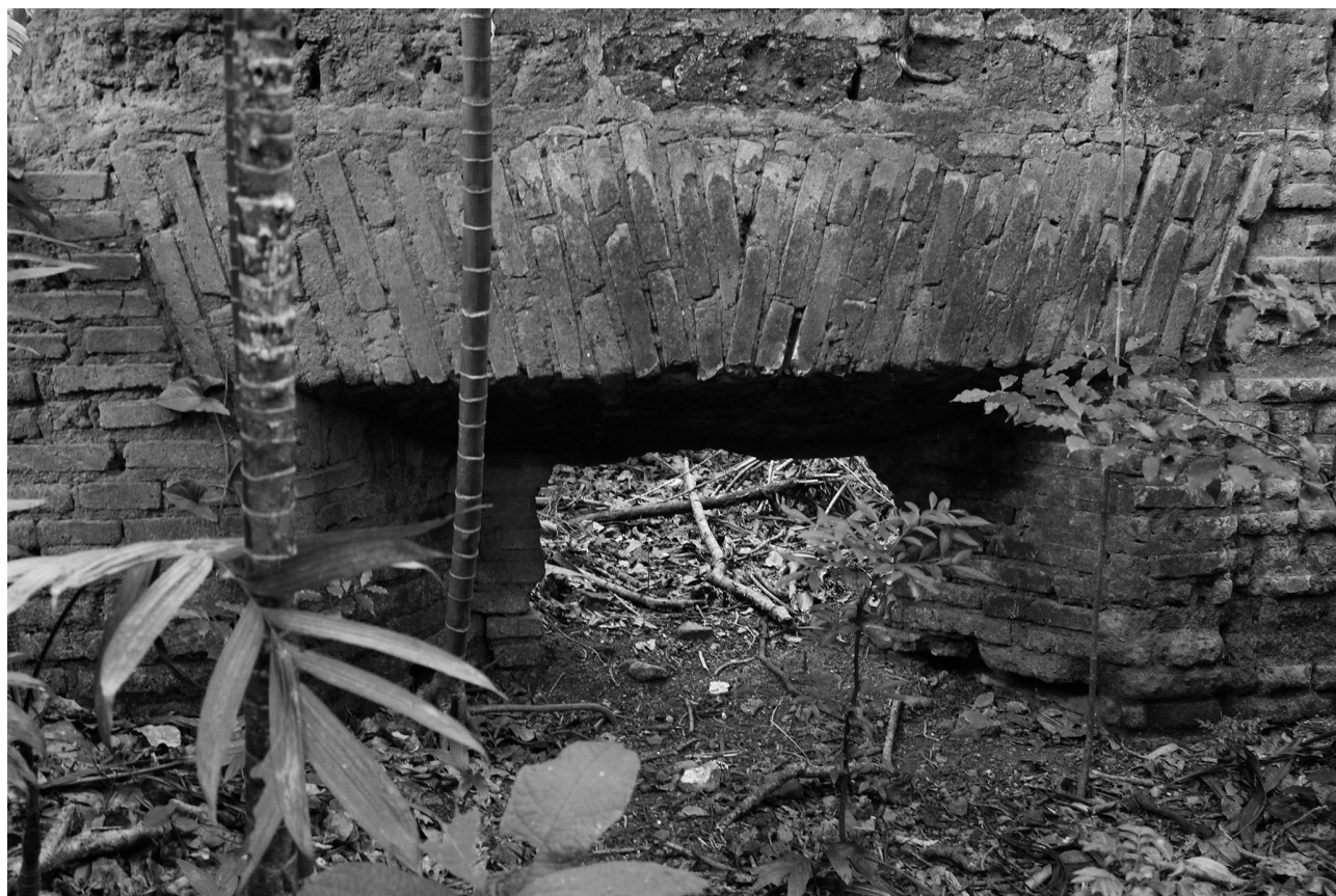
Figura 2. Detalle de dinteles y vanos en el área del ITUGS, kilómetro 45, antigua carretera a Palín – Escuintla.
