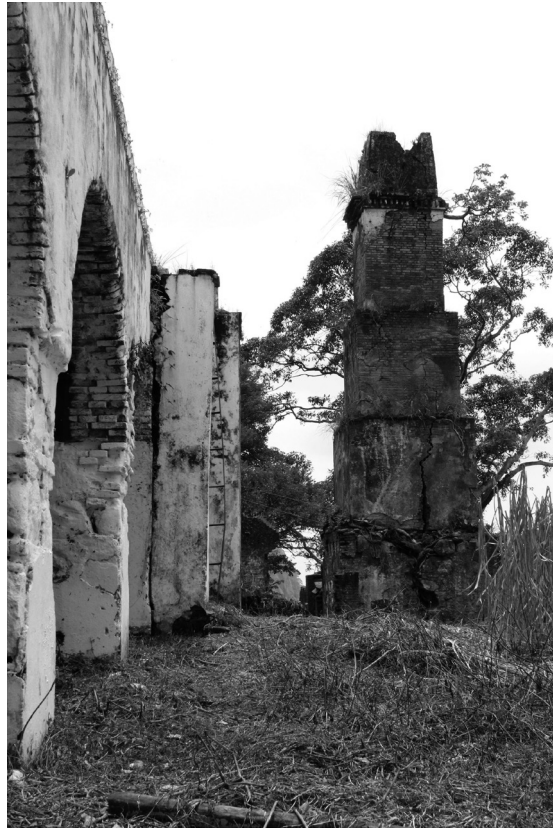
Figura 9. Detalle de acueducto y chimenea de caldera en mampostería de ladrillo.
