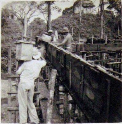
Fig. 9.- Colando trabes de concreto.
