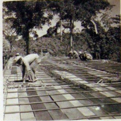
Fig.10.- Preparación del armazón para el techo.
