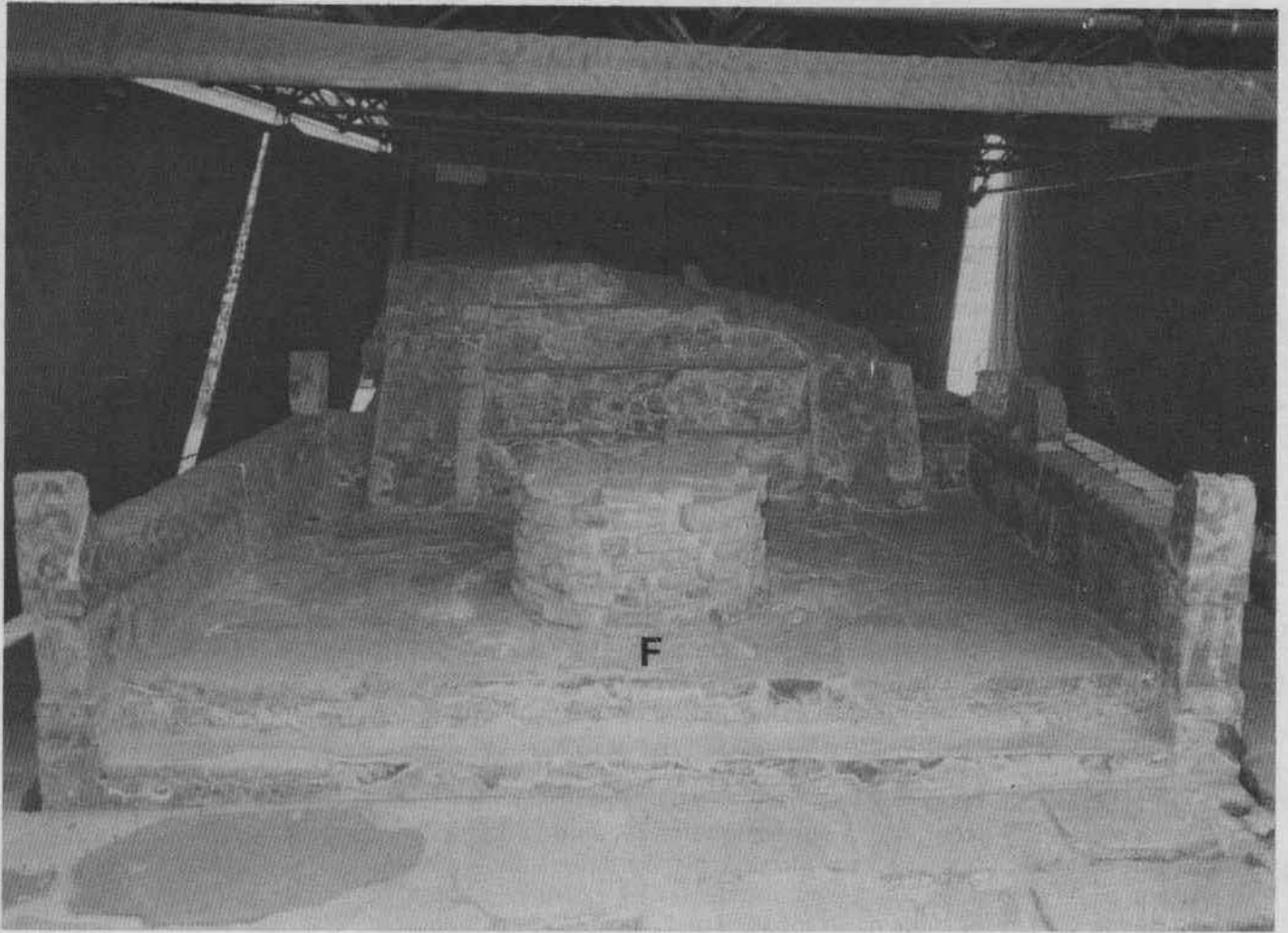
Figura 16. Fachada principal del Edificio F. (Fotografía de Salvador Guil'liem, cortesía del INAH.)
