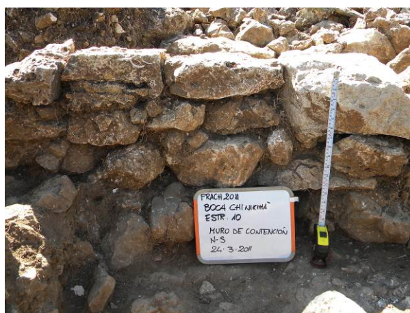
Fig. 9. 21. Op.224, foto muro de contención
