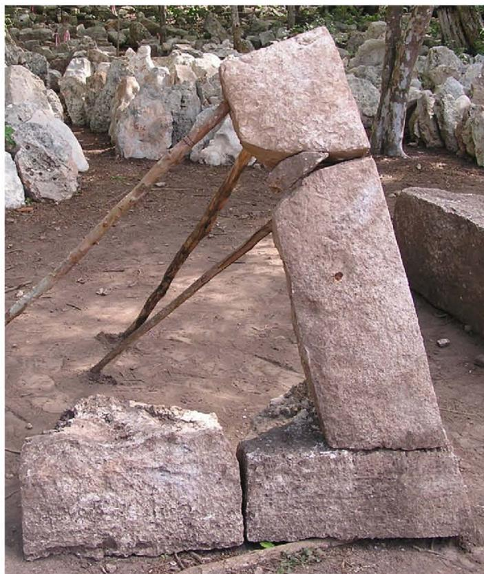
Figura 3.23. Detalle de las piedras que forman la esquina noreste del friso del edificio.
