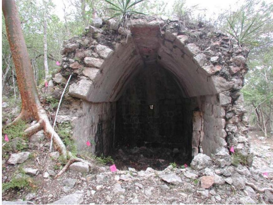
Figura 2.64. Corte N-S de la Estr. N4920E4840, mostrando la técnica de construcción (DSCN7951).
