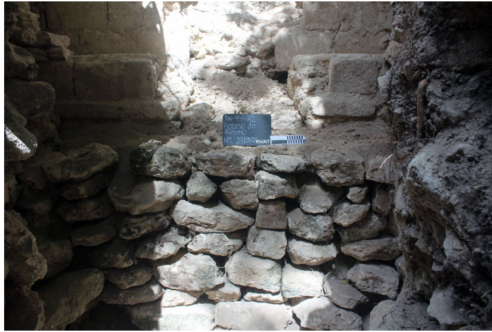
Fig. 4.23 – Muro de relleno construido con piedras de saqueo y colapso de Estr. 13N-2 como parte del proceso de relleno de la trinchera de saqueo TIN-13N2-H2 (Foto: M. F. López).
