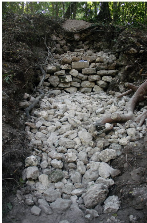
Fig. 4.26 – Vista del proceso de relleno de la trinchera de saqueo TIN-13N2-H4 (Foto: M. F. López).
