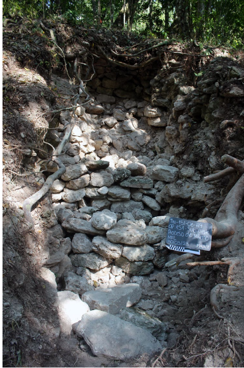
Fig. 4.25 – Muros de relleno construido con piedras de saqueo y colapso de Estr. 13N-2 como parte del proceso de relleno de la trinchera de saqueo TIN-13N2-H4 (Foto: M. F. López).
